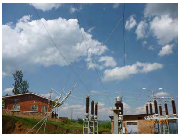
110/15kV ガソギ変電所－2
