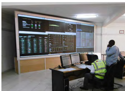
図 2-1-4.1 総合給電指令所の制御室
