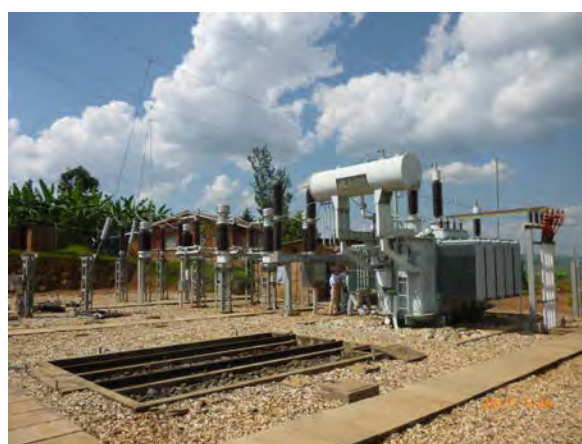
110/15kV ガソギ変電所－1
