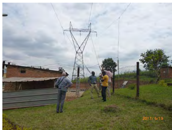
110/15kV ガソギ変電所－3
