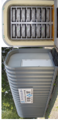
自然氷の冷熱を利用した低温貯蔵庫・アイスシェルター
