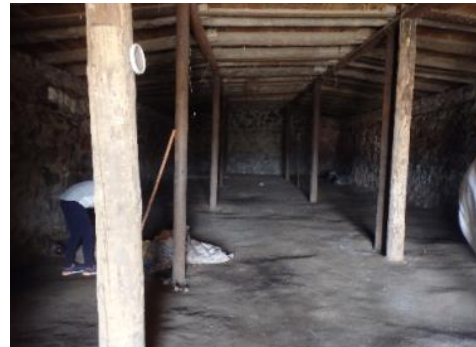
伝統的な半地下式の貯蔵庫(内観) (トゥブ県ボルノール近郊)
