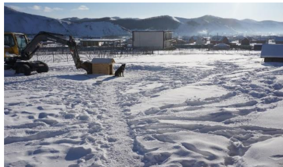
モデル施設建設候補地 (ウランバートル市中心部から車で30分程度)
