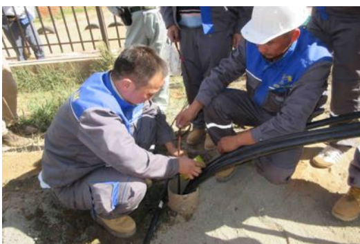
写真 37 Uチューブと温度センサーの挿入-3
