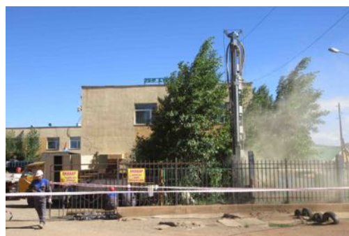
写真 28 ボーリング実施状況
