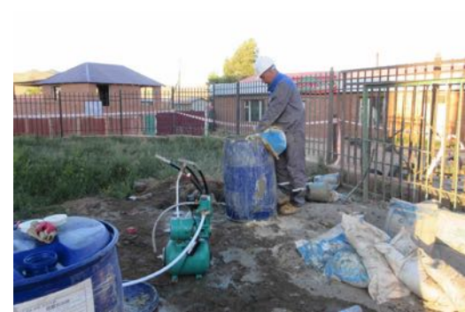
写真 38 ドロマイトの注入
