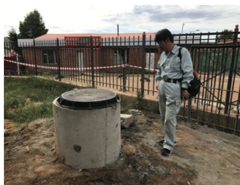
写真 42 井戸上部養生(外部)
