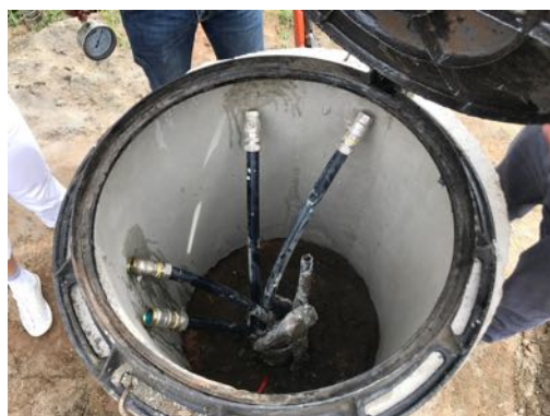
写真 41 井戸上部養生(内部)
