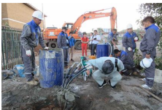
写真 39 ドロマイトの注入を確認
