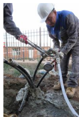
写真 40 6気圧の圧力をかけてUチューブの接続を確認(24時間)
