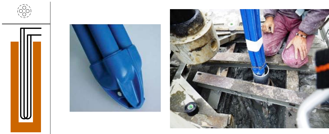
図 18 ダブル U チューブ
