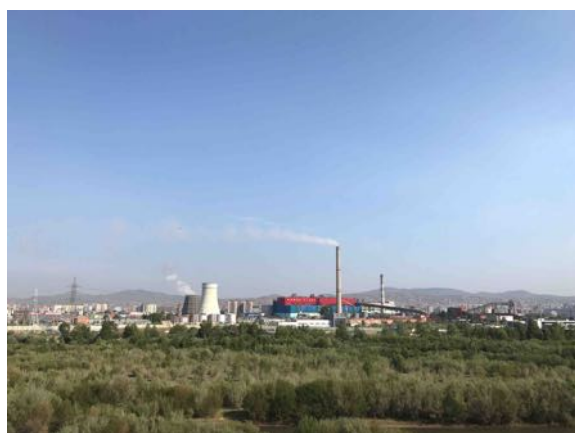
写真 6 第3熱併供発電所
