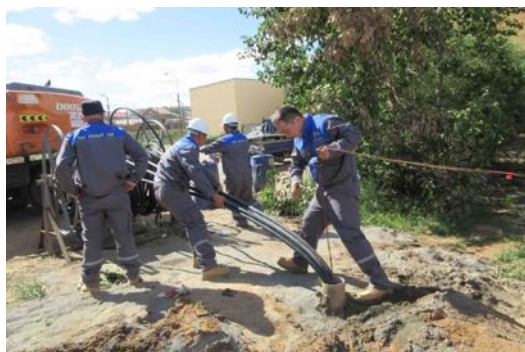
写真 36 Uチューブと温度センサーの挿入-2
