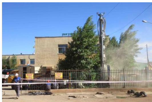
ボーリング実施状況
