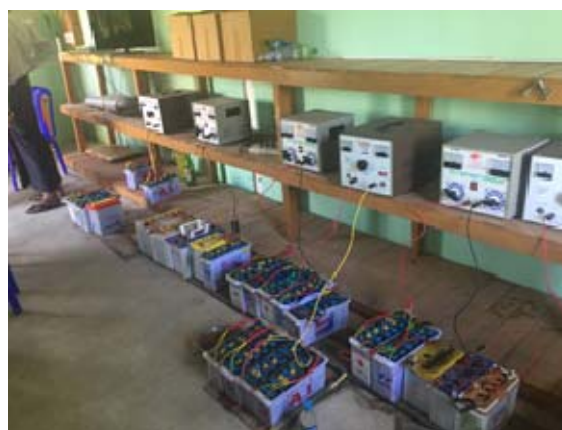
図 3-1-14 パワーキオスク内のバッテリー充電状況
