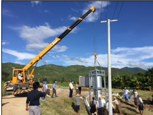
図 3-3-11 パワーアルキメデスの据付状況
