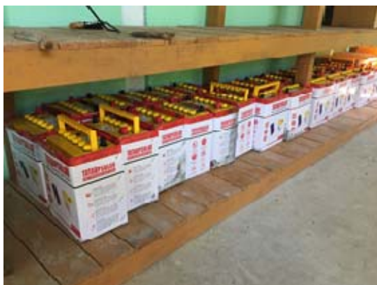
図 3-1-13 新たに投入したディープサイクル蓄電池（2017 年 10 月）
