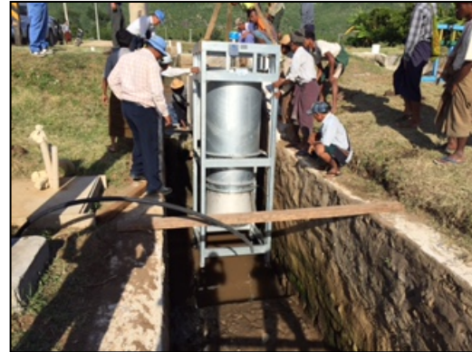
図 3-3-11 パワーアルキメデスの据付状況
