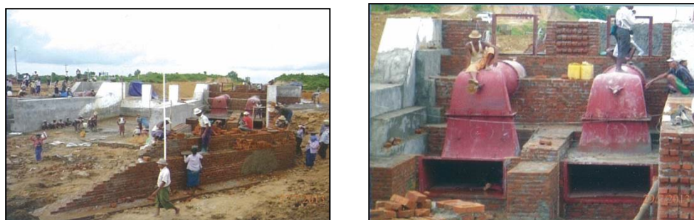
図 3-3-9 バゴー管区におけるマイクロ水力発電装置（出力 20kW）のバイパス工事状況と設置工事
