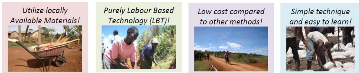
写真 34 土のう工法による道路リハビリテーション CORE/NPO 法人道普請人のホームページより
