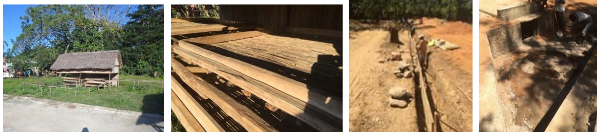
写真 5 HELVETAS 支援によるカカオ乾燥設備(建屋と乾燥棚)と道路補修
