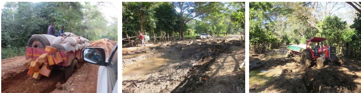
写真 7 轍をつくるトラクター(左)、泥濘化した道路(中央)、スタックしたトラクター(右)
