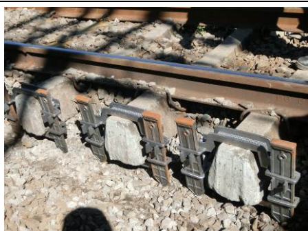
写真3 本体取付け後（JNB）
