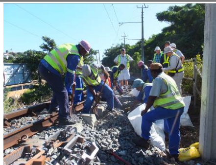
写真4 バラスト掘削状況（DUR）
