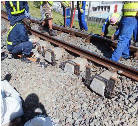
写真 3-2 ダーバン地区での設置作業
