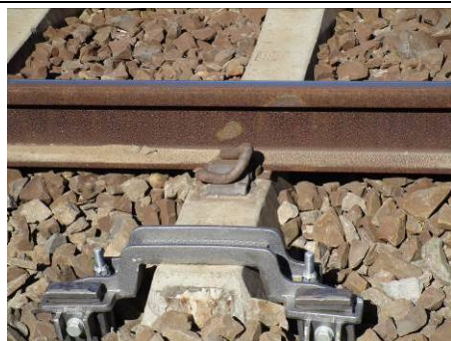
写真7 取付け完了（CPT）
