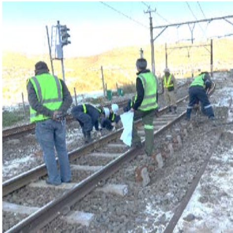
写真 3-1 ケープタウン地区での設置作業
