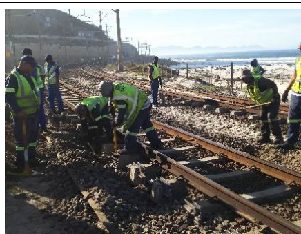
写真6 バラスト掘削状況（CPT）
