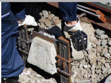
写真5 本体取付け状況（DUR）
