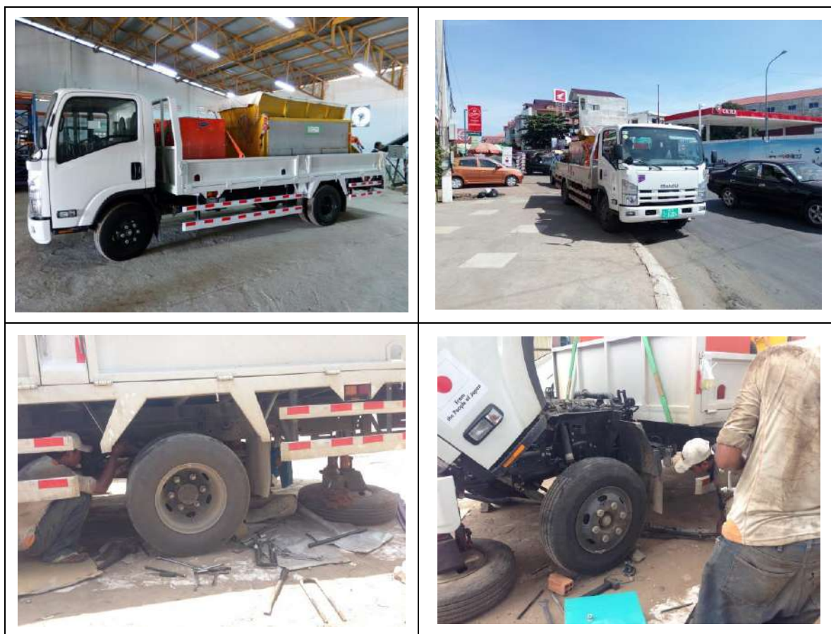
図 3.2-1 メンテナンスカーと車輪サスペンションの補強
