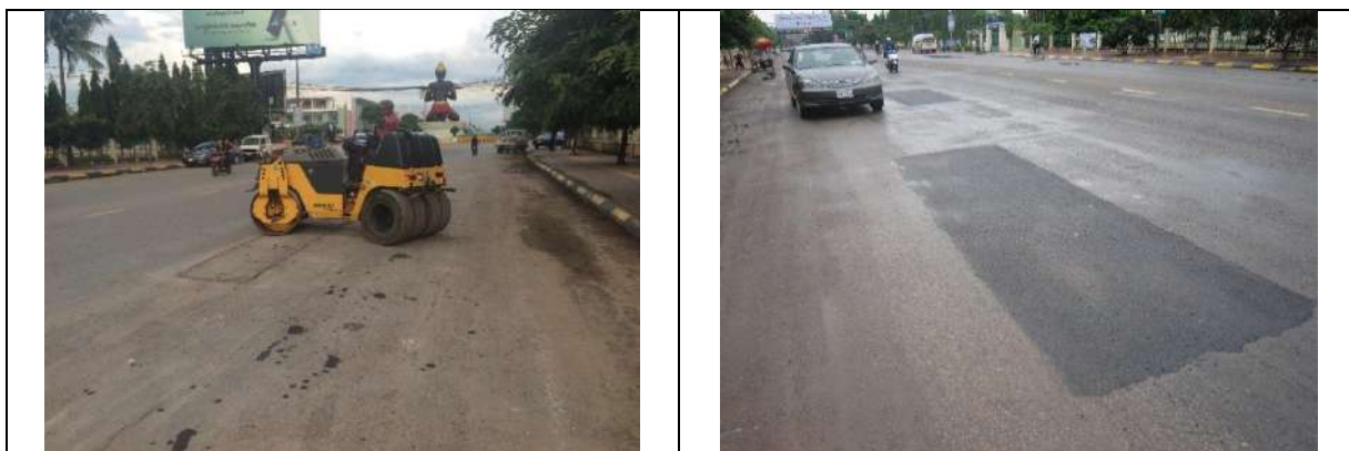
バタンバン州での施工写真
