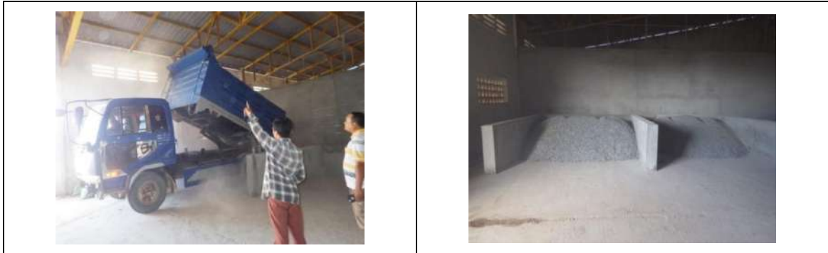
骨材搬入状況
