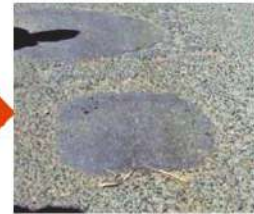
穴があいて水たまりができた道路（上左）も簡単に補修（上右）。全天候型で耐久性が高く、踏み固めるだけで使用できる
