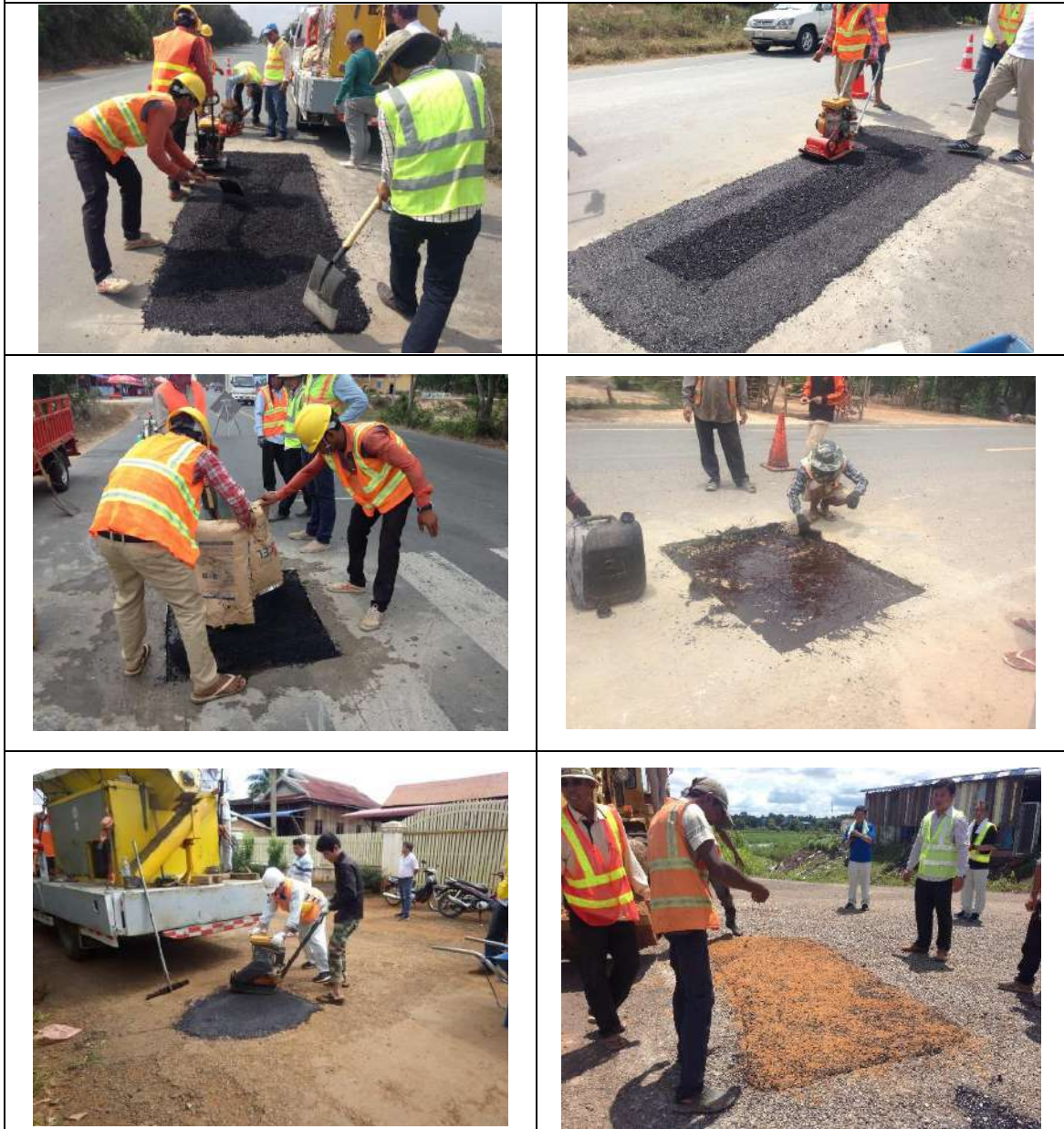
エクセルによる道路補修状況
