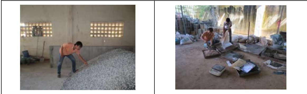
骨材確認状況
