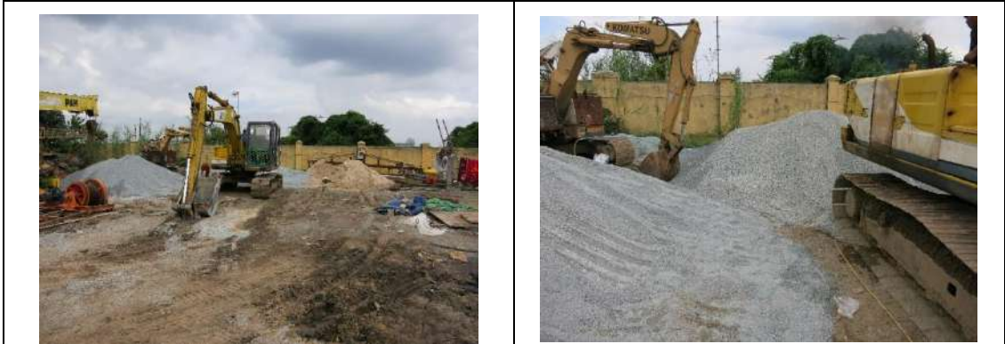
MPWT 自主製造状況 4 (使用材料：碎石，砂)
