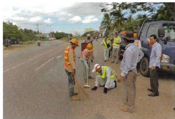
道路補修材「エクセルパッチ」による補修工事
