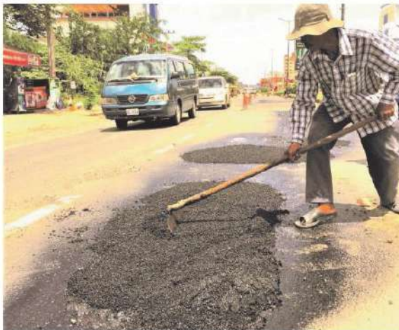
穴があいて水たまりができた道路（上左）も簡単に補修（上右）。全天候型で耐久性が高く、踏み固めるだけで使用できる
