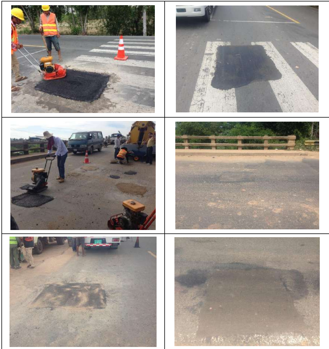
図 3.1-7 エクセル試験施工個所のモニタリング状況
