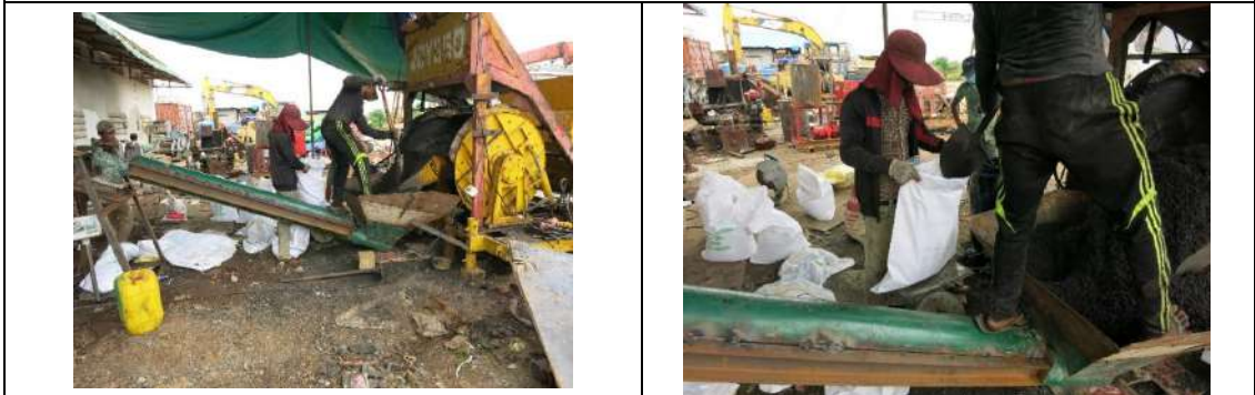
MPWT 自主製造状況 2 (袋詰め状況)
