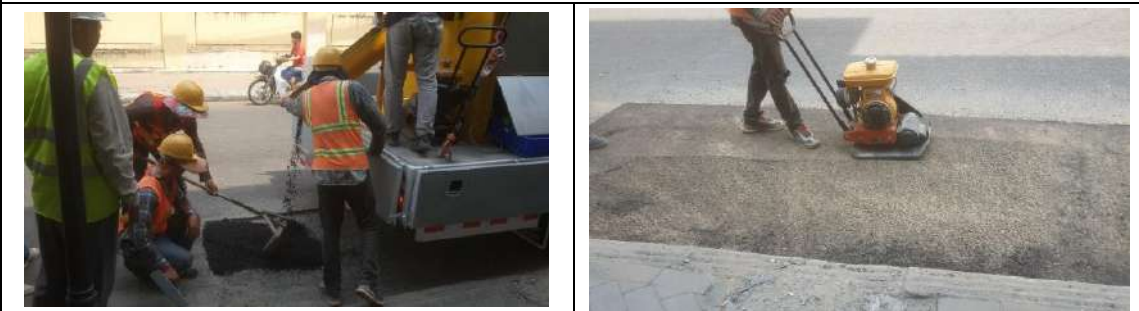
プノンペン信号プロジェクト交差点での試験施工（2017年3月6日）
