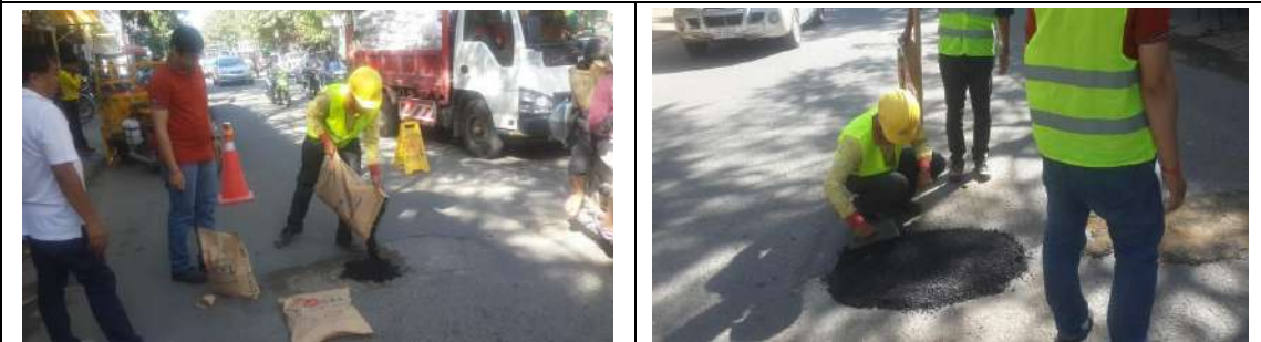
プノンペンロシアマーケット付近での試験施工（2017年2月26日）
