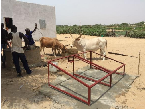
デモ機設置のための架台を設置している様子
