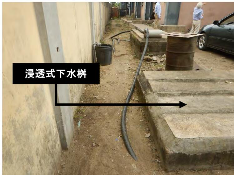
図 2-2-3 アパパロード変電所の浸透式下水枞
