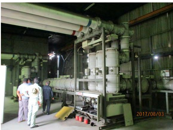
**アパパロード変電所 (132kV GIS の様子)**
