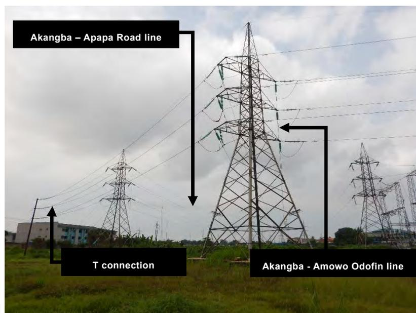
図 2-1-4 アカンバ変電所での1回線T分岐
