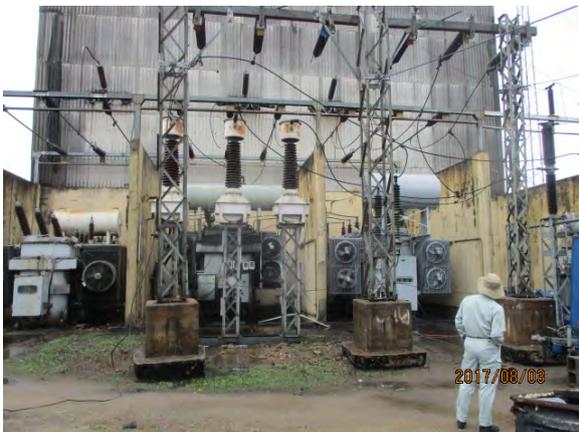
**アパパロード変電所 (132/33kV 変圧器の様子)**
