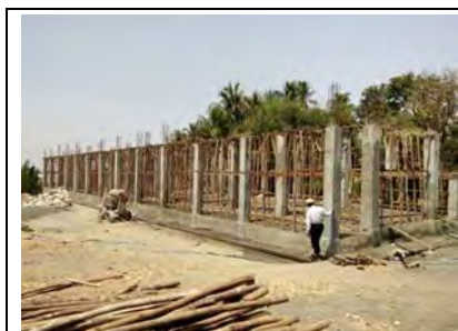
122'x30' 校舎基礎工事 2017 年 8 月
