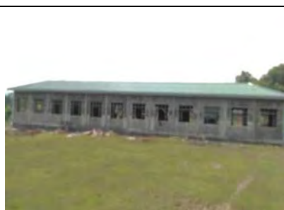
120'x30' 躯体工事 (6 教室) 2017 年 8 月
