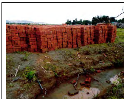
着工準備中(材料運搬) 2016年9月
