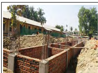
144'x30'校舎基礎工事 2017年2月
