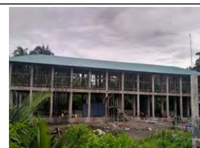
122'x30' 校舎躯体工事 ( 8 教室) 2017 年 9 月
