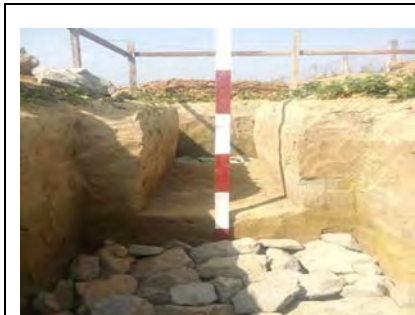
120'x30'校舎基礎工事 2017年2月
