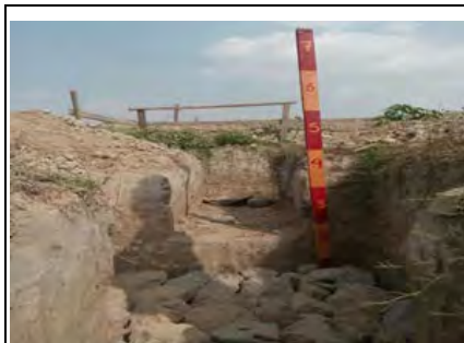
60'x30'校舎基礎工事 2016年9月
