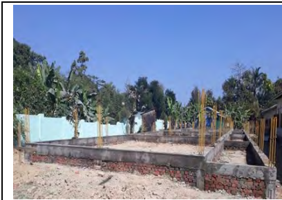
120'x30' 校舎基礎工事完了 2017年2月
