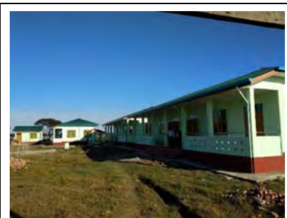
60'x30' 1棟目校舎完成 (3教室) 2018年3月
