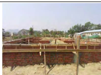
120'x30' 校舎躯体工事 (4教室) 2017年2月
