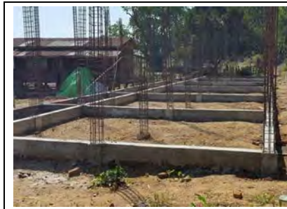
120'x30' 校舎基礎工事(6教室) 2017年3月
