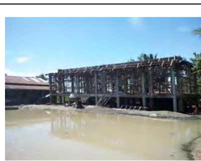
60'x30' 1棟目校舎躯体工事 2017年8月
