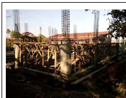
60'x30' 1棟目校舎躯体工事 2017年3月
