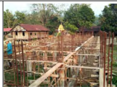
資材運搬困難により遅延 2017年3月
