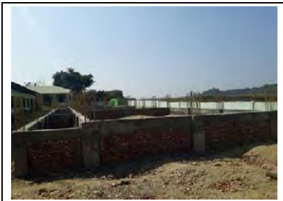
132'x30' 校舎基礎工事完了 2017年2月
