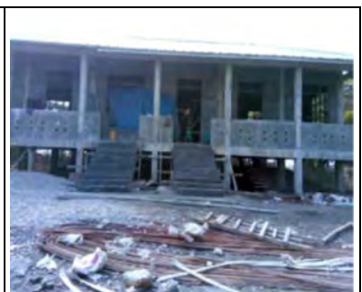
60'x30' 1棟目校舎外観 2017年3月
