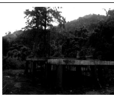
90'x30'校舎1階床躯体完成 2017年9月
