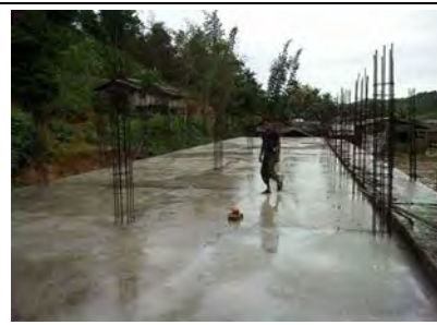
120'x30' 校舎躯体1階床完成 2017年9月
