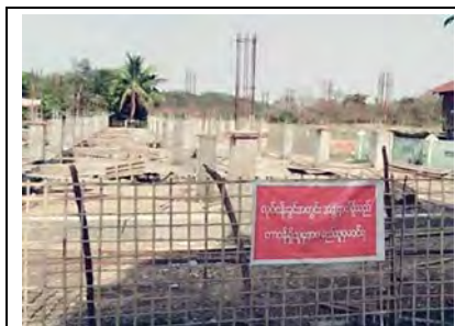
120'x30' 校舎基礎工事 2017年3月
