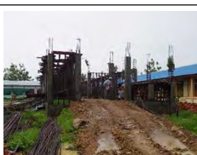
144'x30' 躯体工事(8教室) 2017年6月
