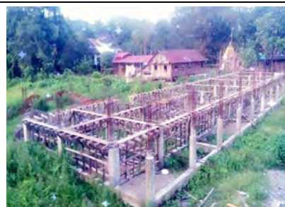
120'x30' 校舎躯体工事 2017年9月
