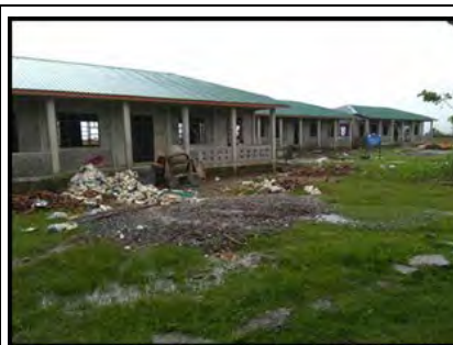
60'x30' 1棟目躯体工事 (3教室) 2017年9月
