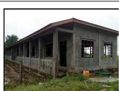
120'x30' 躯体工事(6教室) 2017年9月
