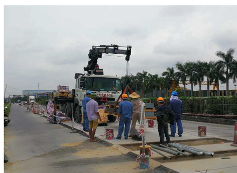
WIM基礎工事
