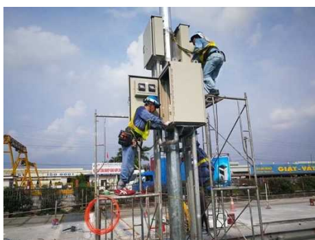
制御盤の設置
