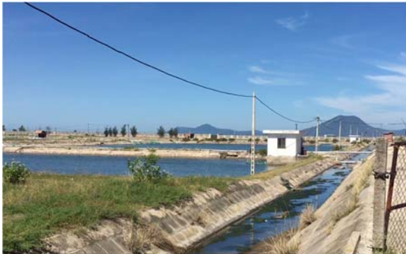
実証実験場野外水槽
