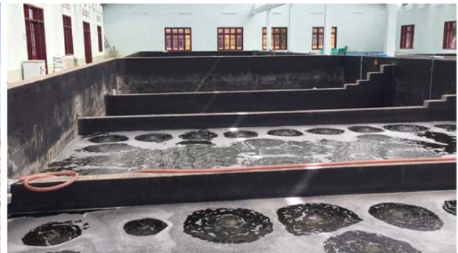
実施実験場屋内水槽
