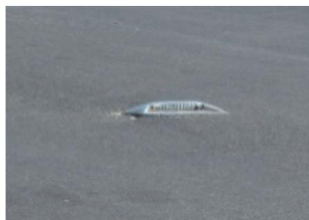
写真：現地で設置されてる反射板（キャッツアイ）
