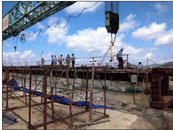
(d) Ha Long – Hai Phong Expressway
