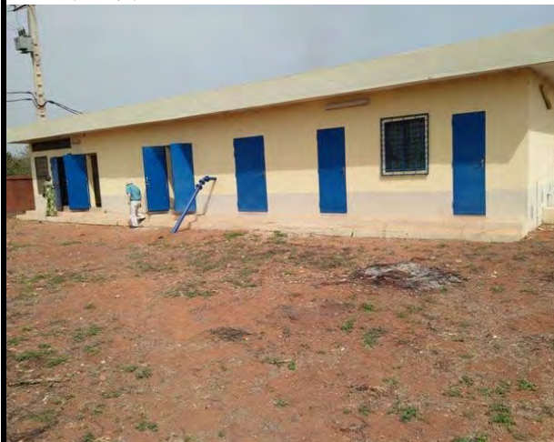
水源井戸建屋(Kétou well 1) (KfW-オランダ支援 2013)
