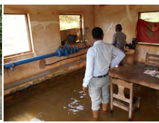
ドボ井戸管理棟 (水没風景)
