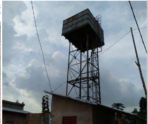
高架水槽 (154m 3 , スチール製, Djakotomey)
