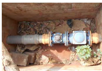
PVC φ 160mm (水源井戸～ジャコトメ中継ポンプ～アゾベ高架水槽の区間)
