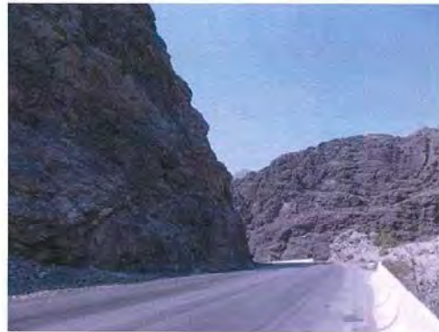
Место проведения строительных работ по предотвращению камнепадов
