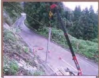
クレーンによる材料搬入
