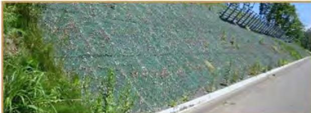
斜面に設置することで、土砂の土圧を受け止めたり、流水による斜面の浸食を防ぐ。
