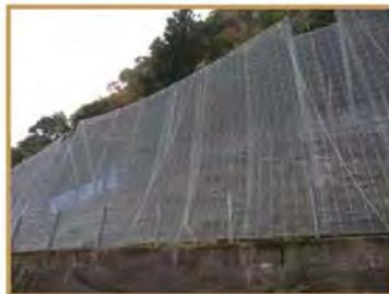
Противокампнепадная продукция, которая захватывает камни с помощью проволочной сетки, а также безопасно направляет их на дно склона.
