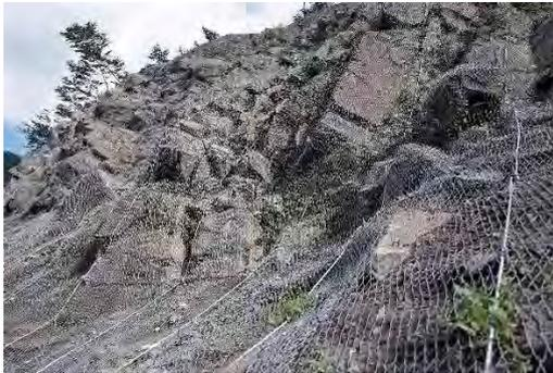
提案製品① 密着式安定型落石防止網
