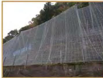
発生した落石を金網で受け止め、斜面最下部に安全に導く落石対策製品。
