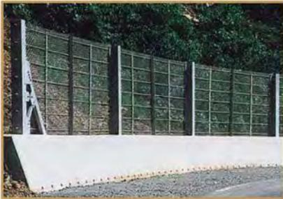
ケーブル・金網・支柱の塑性変形で発生した落石のエネルギーを吸収し、保護対象物に接触させない。
