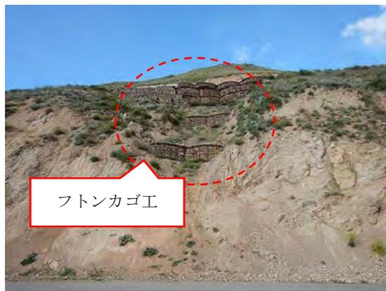
写真 1-2 既存の斜面崩壊対策（フトンカゴ）
