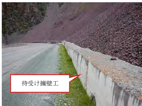
写真 1-1 既存の落石対策（待受け擁壁）
