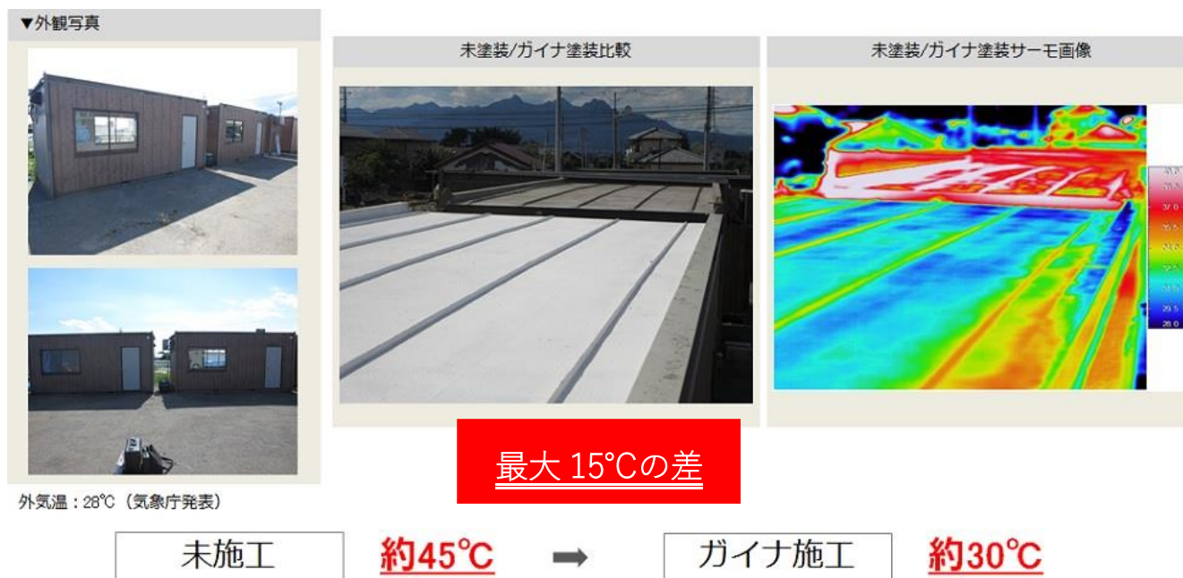
写真 2：ガイナ塗装箇所のサーモグラフィー比較 1
