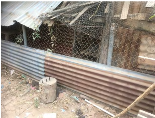
既存の腐敗槽（レストランの地下）
