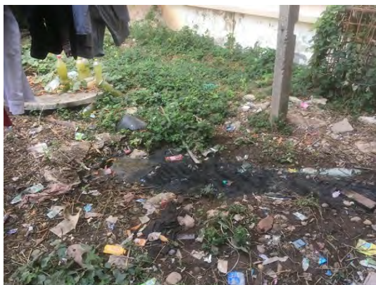
既存の排水管と腐敗槽
