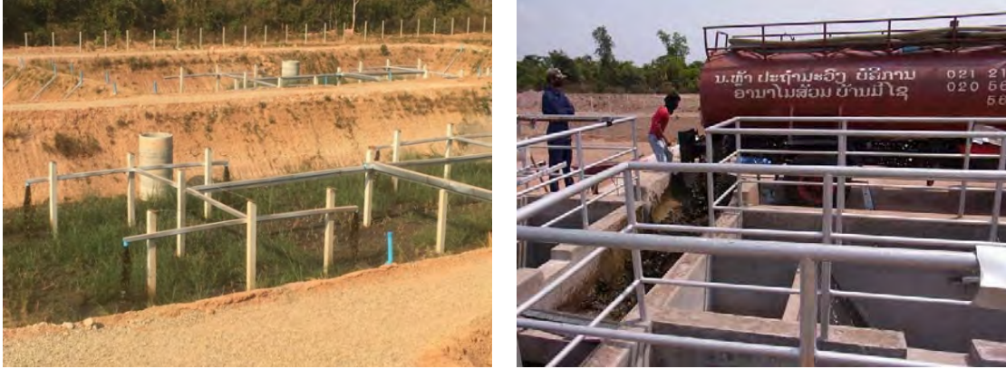
KM21 に建設された汚泥処理施設と引抜きトラックによる汚泥の運搬、投入の様子
