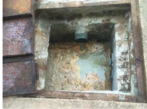
既存の腐敗槽
