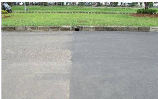
試験施工 (2017年11月)
