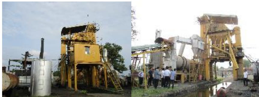
注：左の写真は入口から撮影、右の写真は出口から撮影 写真 7 既設のアスファルト製造プラント
