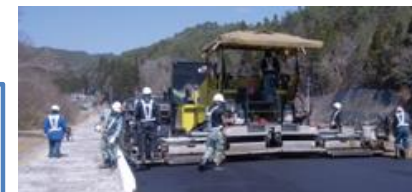
再生アスファルトを活用した舗装
