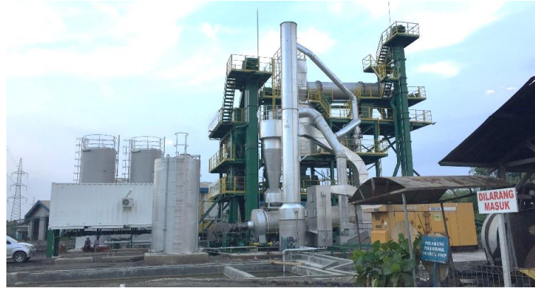
写真2 カラワンのアスファルト再生プラント
