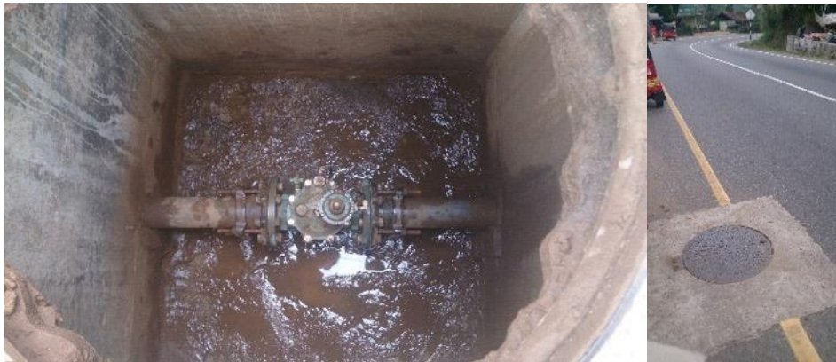
図 2.5 Alawathugoda 地区 Pitiyagedara のサンプル PSV の設置状況 出所：調査団撮影
