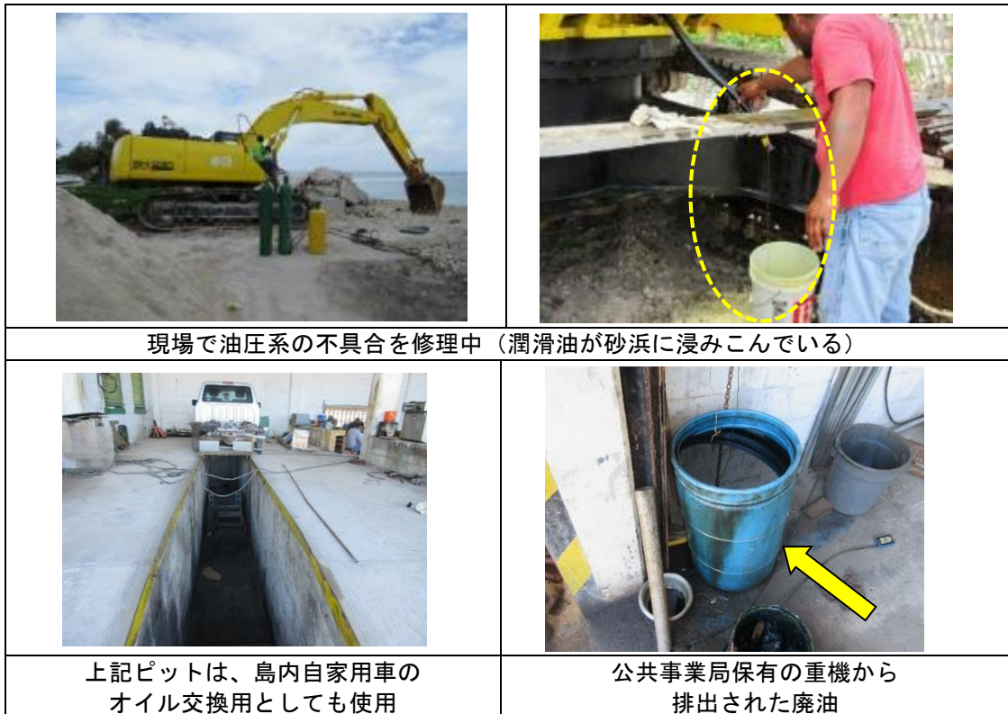
写真 1-9 漏油の現状（イバイ発電所）
