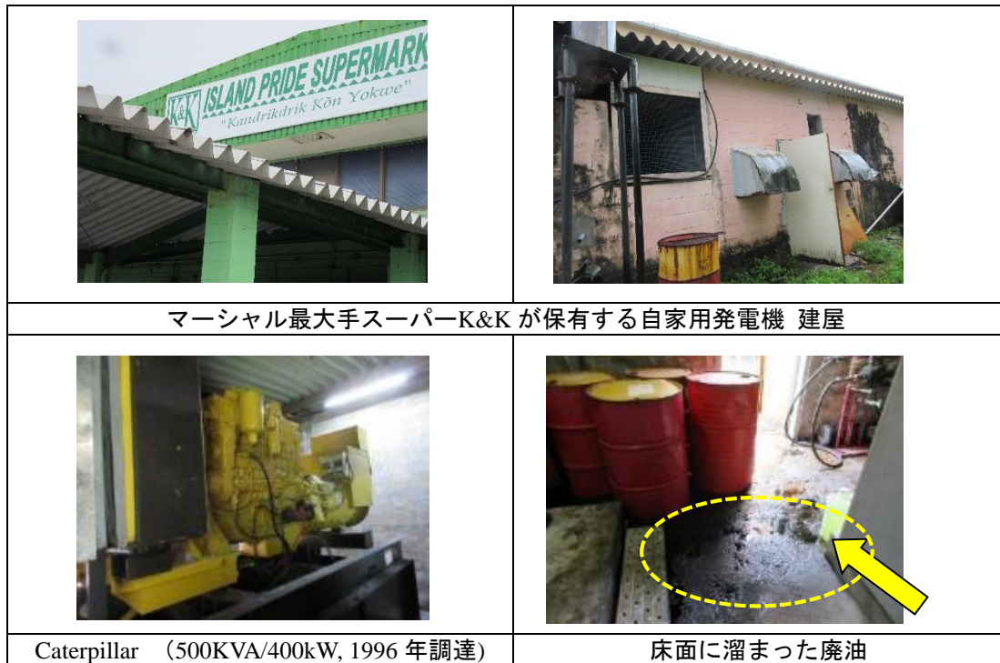
写真 1-5 マジロ最大手スーパー保有のバックアップ用発電機 （K&K Island Pride Supermarket）
