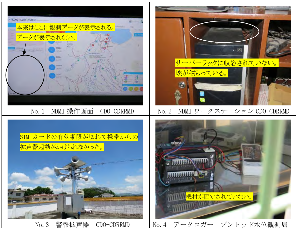
図 2-4 NDMI 監視局 (CDO-CDRRMD) の状況
