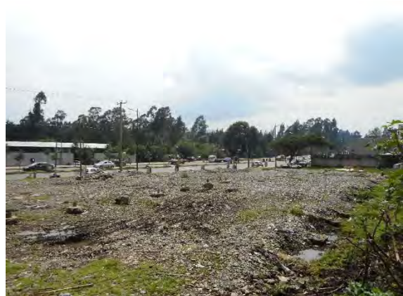
写真-8：建設予定地 既存倉庫撤去跡 コンクリートの基礎や瓦礫が部分的に残存している。
