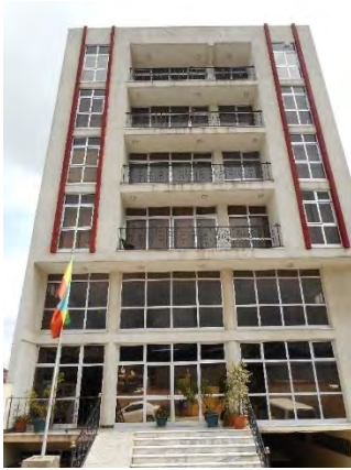
写真-1 : EKI 本部 ビル外観 地下 1 階地上 6 階の鉄筋コンクリート造。
