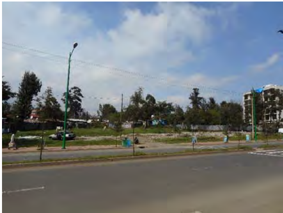
写真-9：道路の反対側より建設予定地を見る。歩道と予定地の間には高低差がある。
