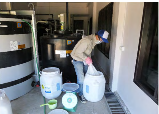
浄水場建設現場 薬品溶解 撮影日 2016年10月5日
