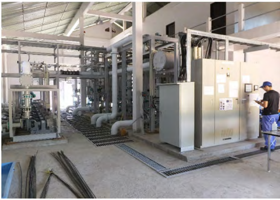
浄水場建設現場 装置運転状況確認 撮影日 2016年10月5日
