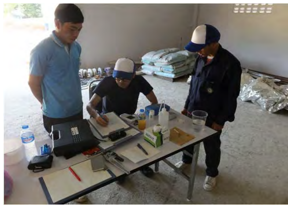
浄水場建設現場 水質分析 撮影日 2016年10月3日
