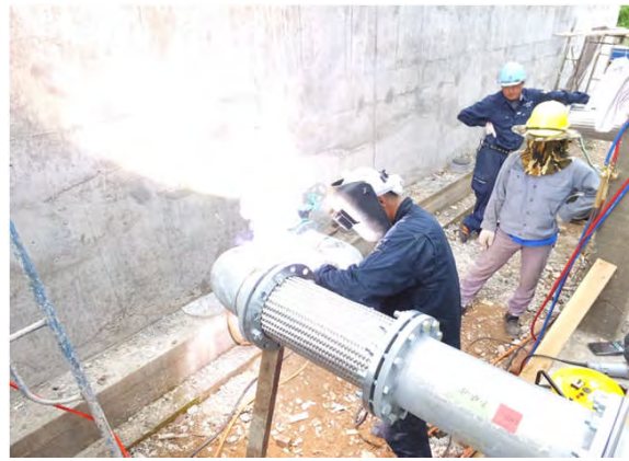
浄水場建設現場
