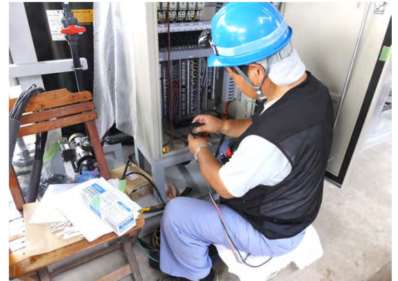
浄水場建設現場
