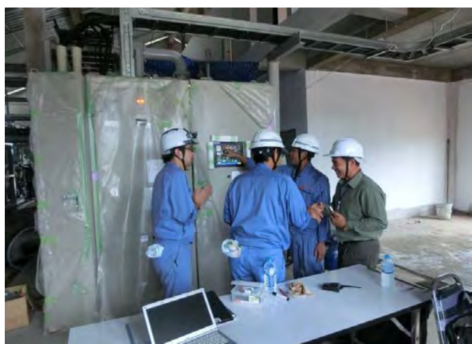
浄水場建設現場
