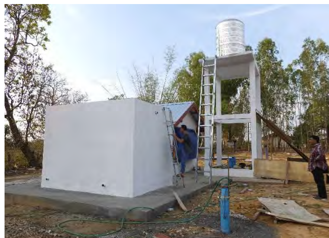
浄水設備施工状況②(右下青いパイプが井戸)
