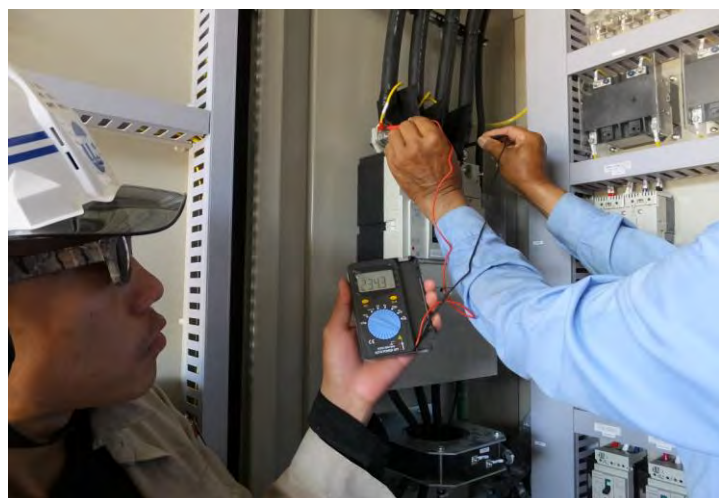
浄水場建設現場
