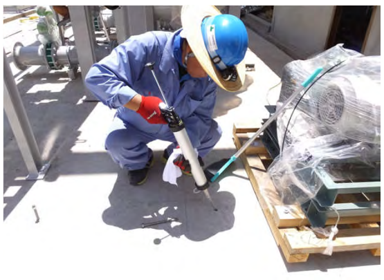
浄水場建設現場
