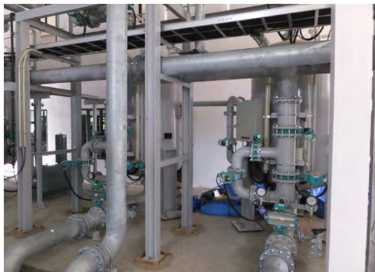
浄水場建設現場 上向流 アクティブファイバー ろ過装置 UA-1.2 撮影日 2016年9月30日
