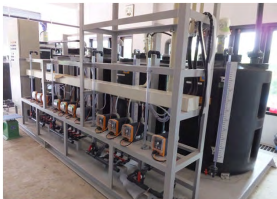
浄水場建設現場 溶解タンク 左:硫酸バンド用 右:殺菌剤用 撮影日 2016年9月30日
