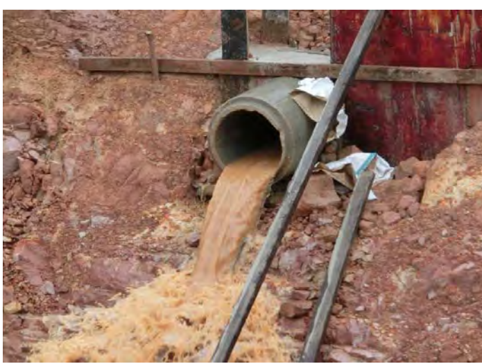
浄水場建設現場
