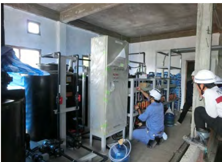
浄水場建設現場
