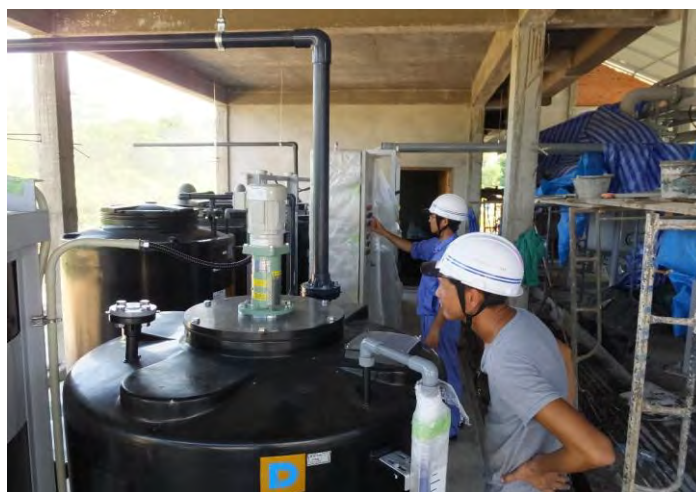
浄水場建設現場
