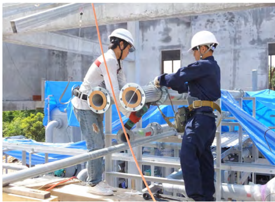
配管接続作業
