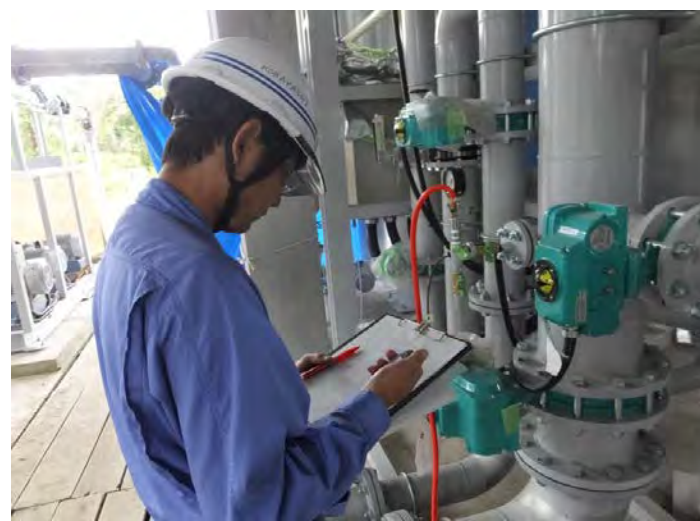
浄水場建設現場
