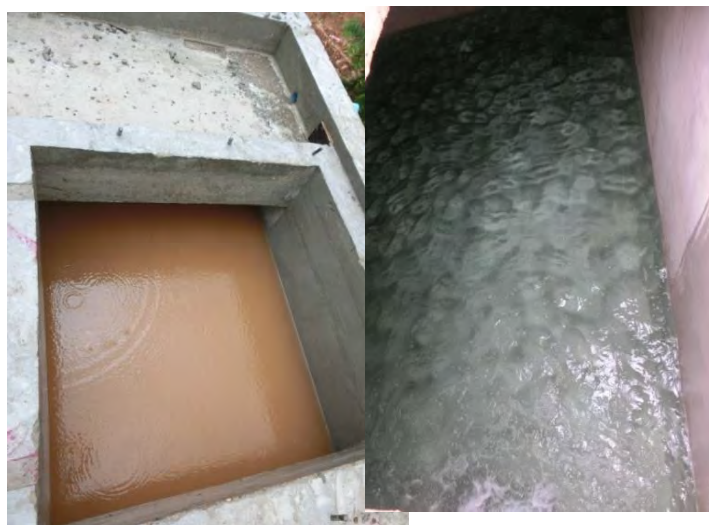
浄水場建設現場
