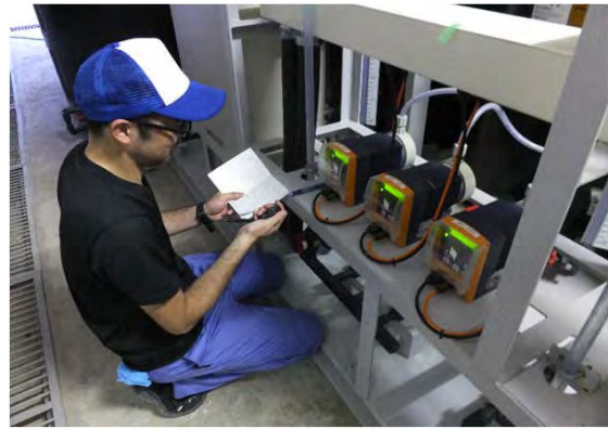
浄水場建設現場 薬注量検定 撮影日 2016年10月5日
