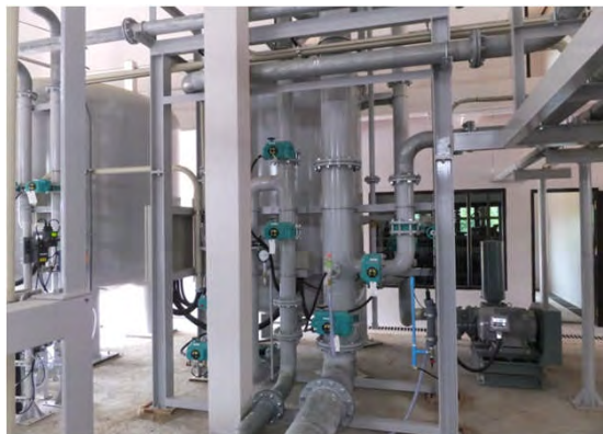
浄水場建設現場 上向流 アクティブファイバー ろ過装置 UA-1.2 撮影日 2016年9月30日
