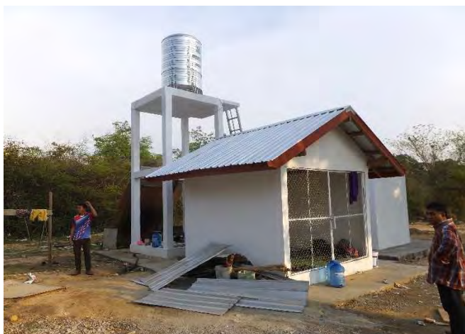
浄水設備施工状況①
