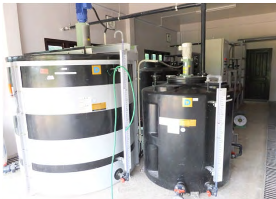
浄水場建設現場 溶解タンク 左:硫酸バンド用 右:殺菌剤用 撮影日 2016年9月30日
