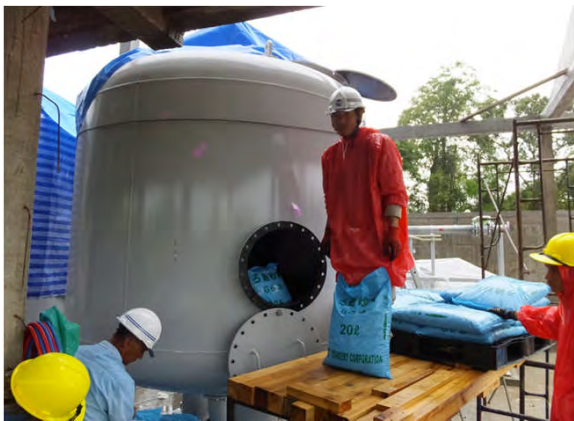
浄水場建設現場
