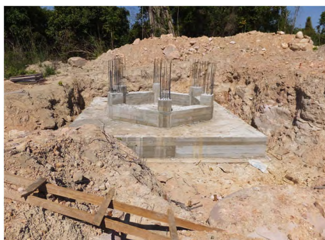
高架水槽基礎
