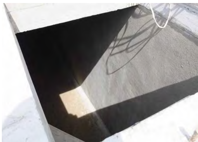
水槽内部(防水塗装未実施)
