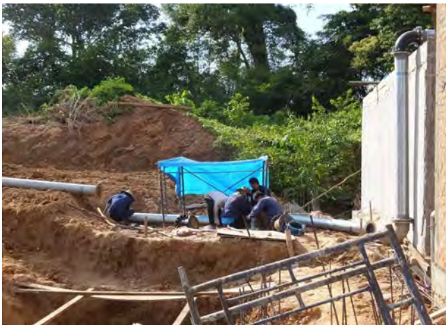
取水施設(水槽接続部)
