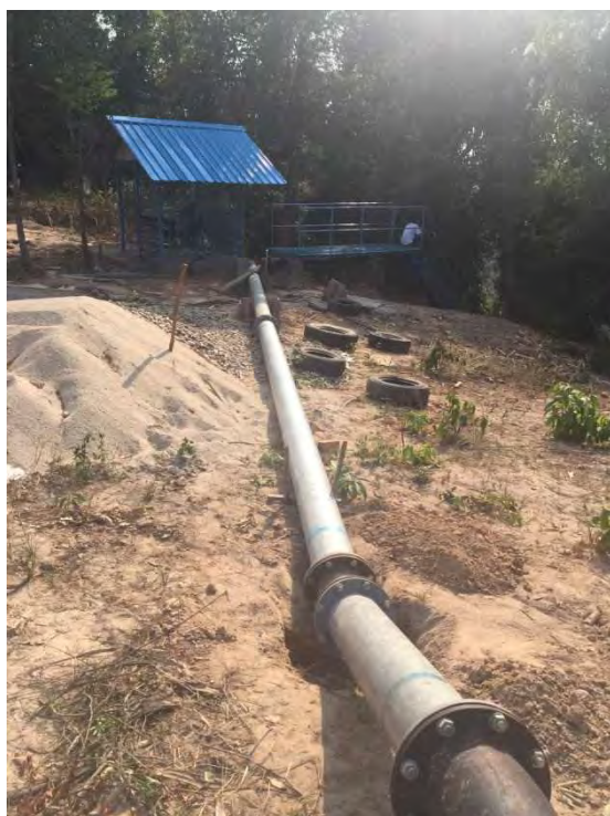
配管（取水箇所から水槽）
