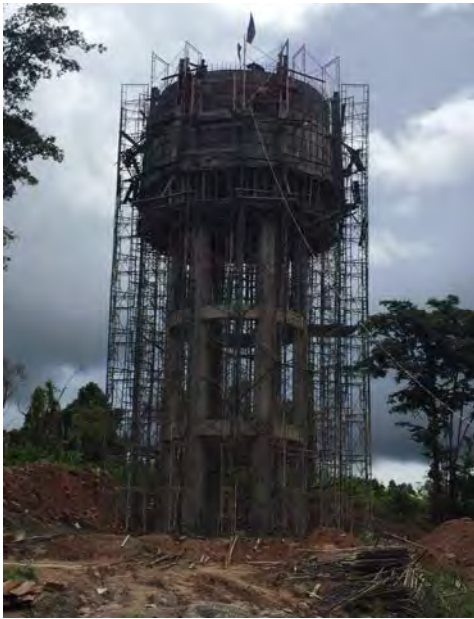
高架水槽 外観
