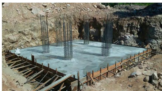
高架水槽基礎
