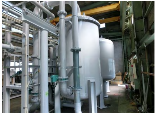
下向流アクティブファイバーろ過装置
