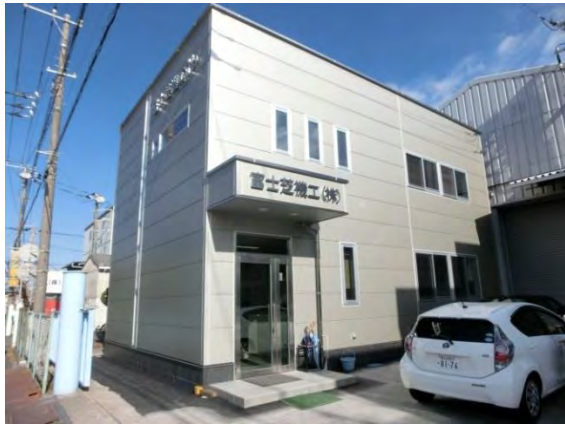
製作工場事務所
