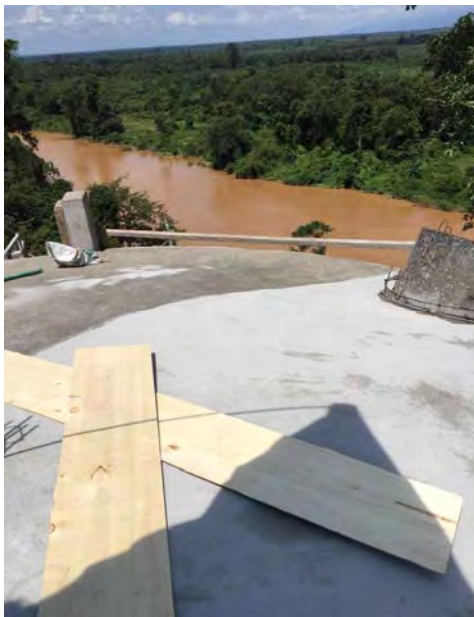
高架水槽 上部
