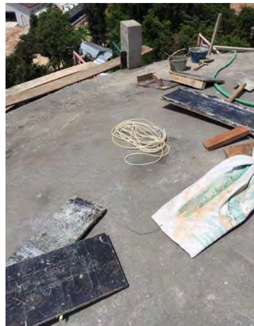
高架水槽 上部
