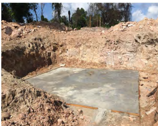
高架水槽基礎
