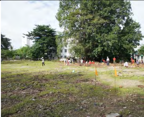
写真 1 : 建設予定地 先方負担により既存樹木の伐採が行われる。
