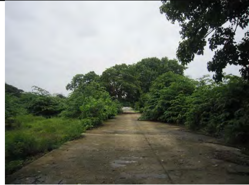
写真 2 : 建設予定地 先方負担により既存舗装部分の撤去が行われる。
