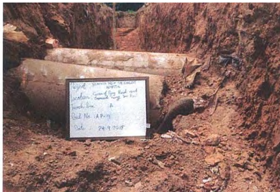
B 地点：使われていないコンクリートの排水管(φ1.5ft×2本)が見つかった。
