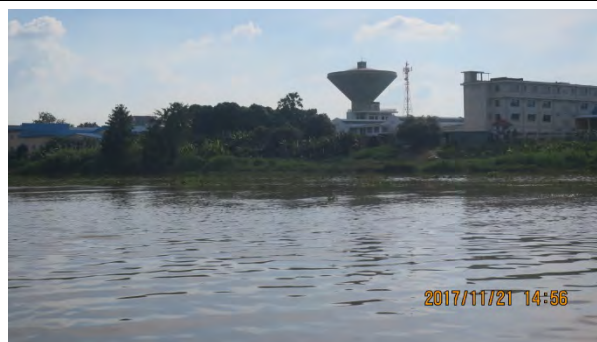
写真 1-2 : タクマウ浄水場取水地点 (2017年11月)
