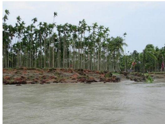
浸食される河岸。自然の護岸であるため、災害等に脆弱である。
