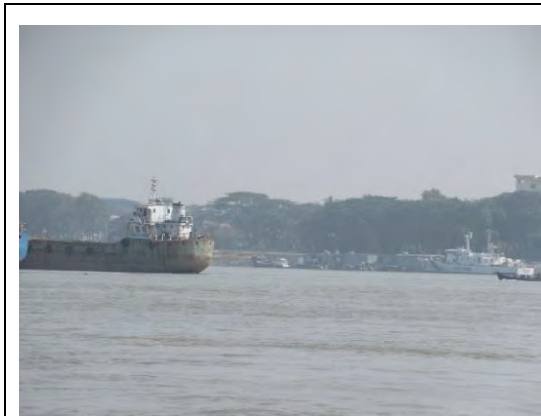
対岸にある CG Base Chittagong 船艇係留施設遠景。ここで完工工事が行われ、確認試験後 BCG に引き渡される計画。
