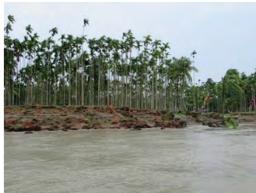
浸食される河岸。自然の護岸であるため、災害等に脆弱である。
