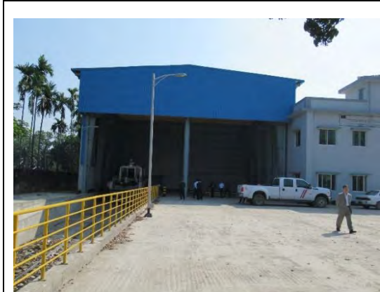
米国の支援で建設された CG Base Chittagong Repairing Centre。
