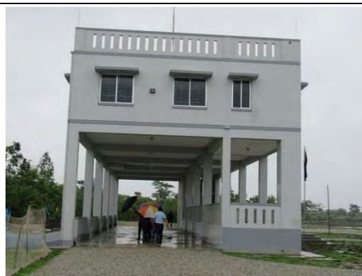
CCMC には、非常用発電機、ソーラーシステム、貯水槽等が設備され、災害発生時には、避難した住民が数日滞在することが可能。
