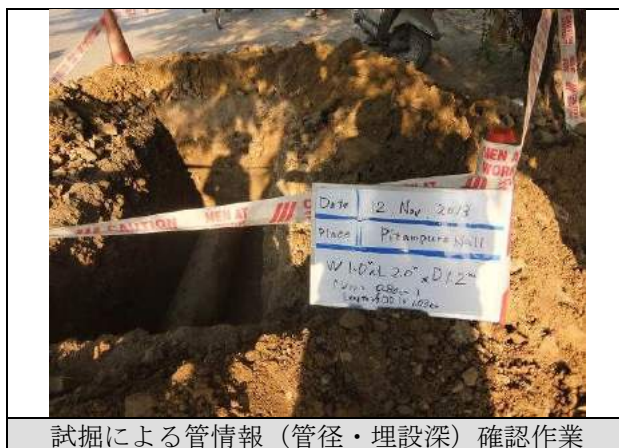
図 3-5 試掘調査結果による管情報の変更箇所
