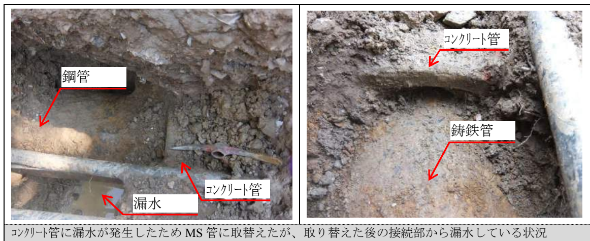
図 3-6 工事状況写真
