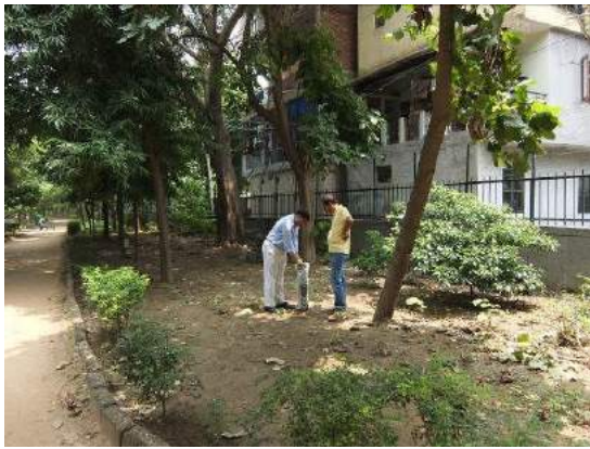
DJB との配管位置確認作業 -1-
