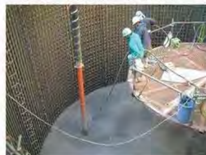
図4 主鉄筋の組み立て 3)
