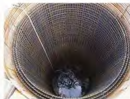
図4 主鉄筋の組み立て 3)
