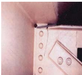
-fatigue crack-
