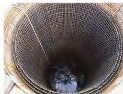
図4 主鉄筋の組み立て 3)
