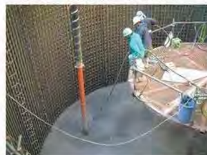
図4 主鉄筋の組み立て 3)
