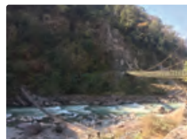
レオタラ橋の旧橋(手前)と新橋(奥)
