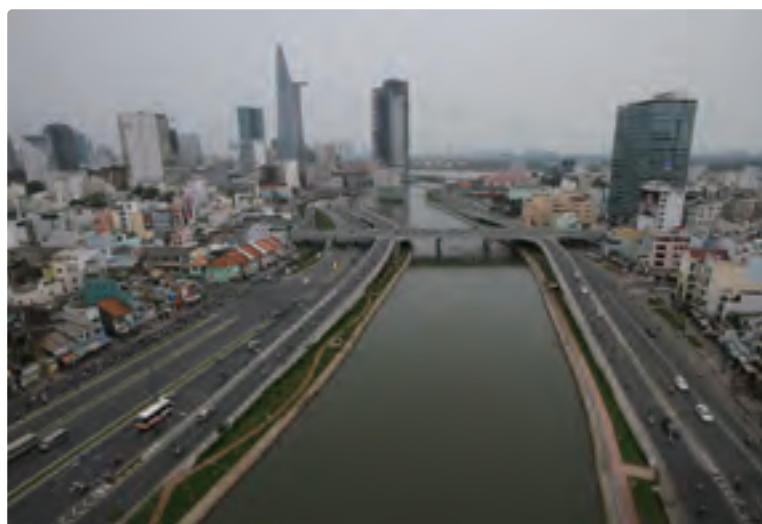
本事業で整備された道路(左側)(施工監理コンサルタント提供)
