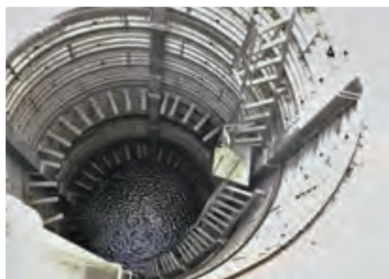
エル・ベリンチェ地区の集水井とその内部（扇状に配置された集水ボーリング工が見える）
