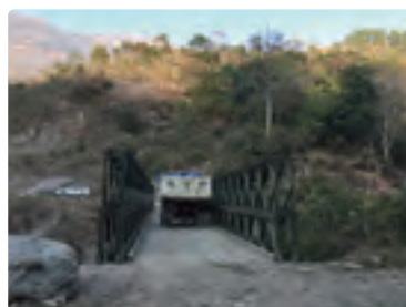
建設後のケラ橋
