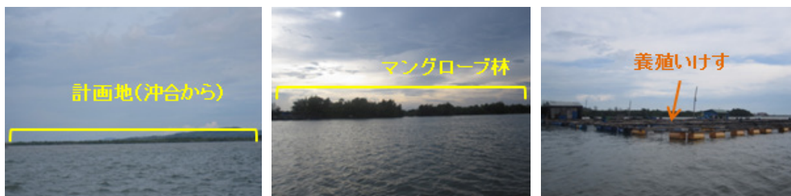
図 11.1.3 カイメップハーLogistics Park Project 予定地現況（調査団撮影）
