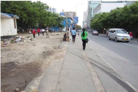
工事实施前は公園内の舗装が施工されていなかった。
