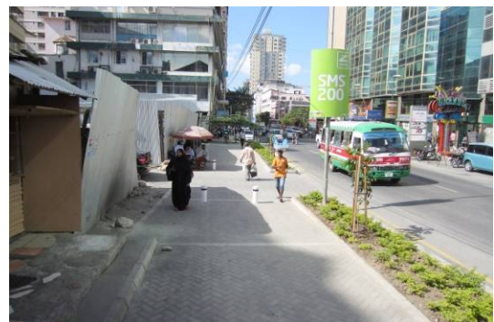
歩道と植樹帯の整備を行い、違法路上駐車を排除するとともに、良好な歩行者空間を創出。
