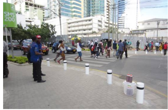
植樹帯の設置と横断歩道の路面標示と道路標識を設置した結果、ランダムな車道横断はなくなった。
