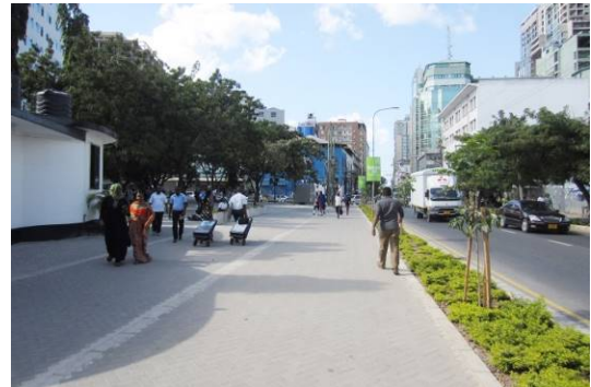
車道と歩道との間に植樹帯を設け、公園内もインターロッキング舗装を施工。
