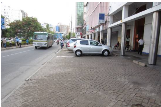
工事実施前は、建物前の歩道部分は駐車スペースとして利用されており、歩行者は車道上を歩いていた。
