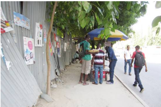
工事实施前は歩行空間がほとんどなく、歩行者は車道を歩いていた。
