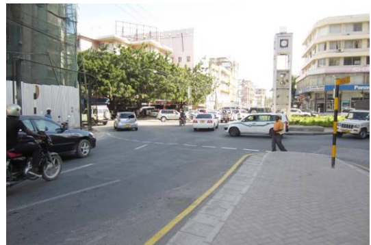
サモラ・アベニューからの流入部分のみ、ラウンドアバウトを2車線に拡幅し、円滑な交通流を確保。
