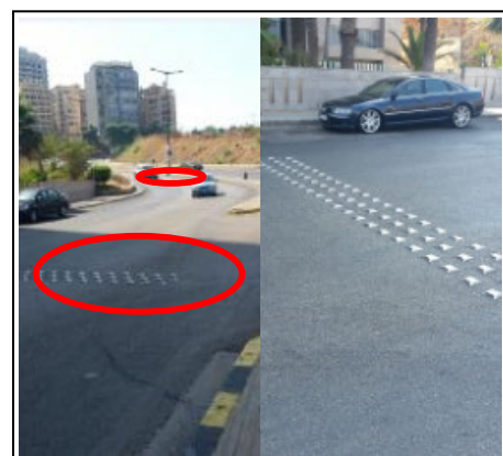
写真 曲線部のチャッターバー設置
