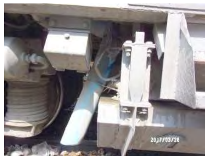
(d) Sewage Storage Tank
