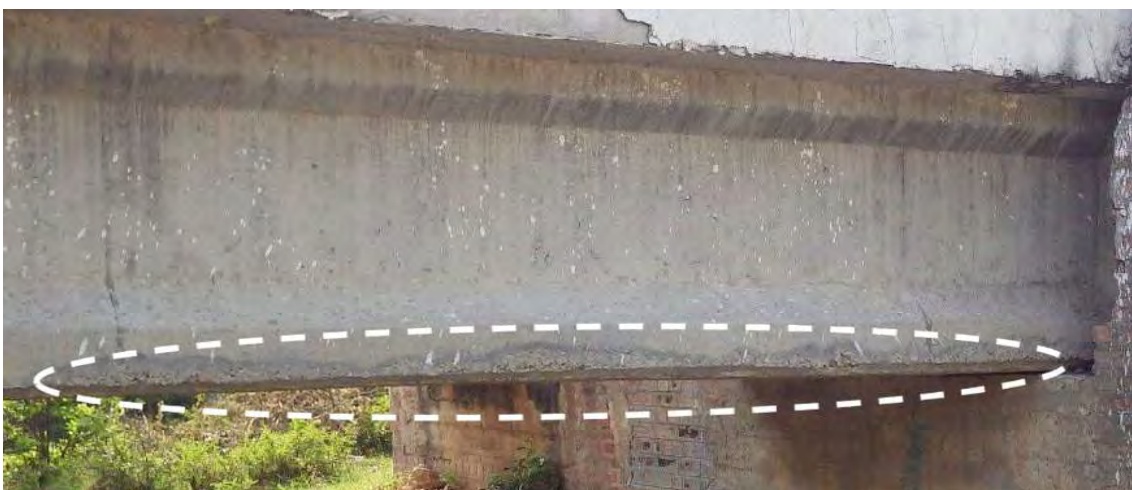
図 5.5.15 使用材料や施工の不良による耐久性低下 (Bridge No.270)
