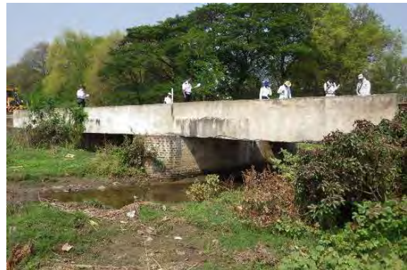
鉄筋コンクリート桁
