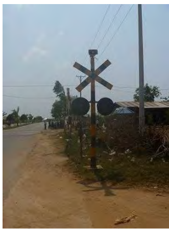
(a) 警報器(道路側)
