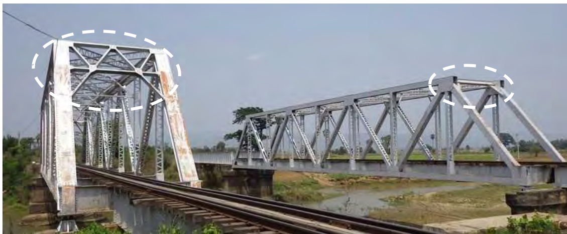
図 5.5.8 建築限界に対する橋門構の干渉（Bridge No.373）
