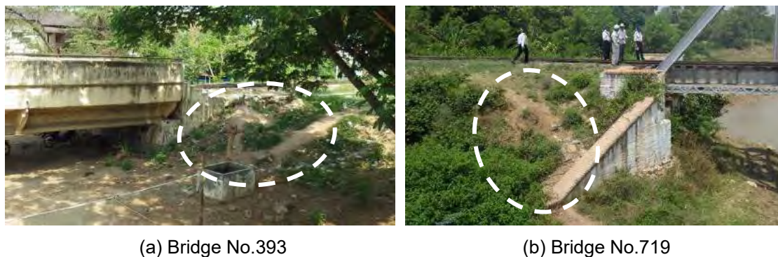
図 5.5.28 盛土材・バラスト材の流出
