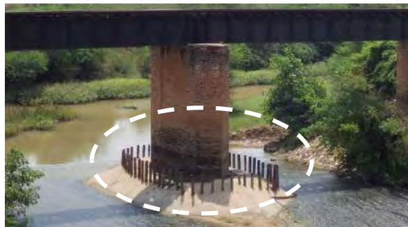
図 5.5.22 洗掘防止工（Bridge No.699）
