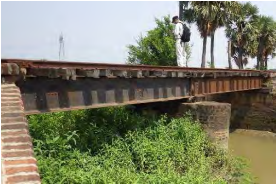
鋼製上路式プレートガーダー
