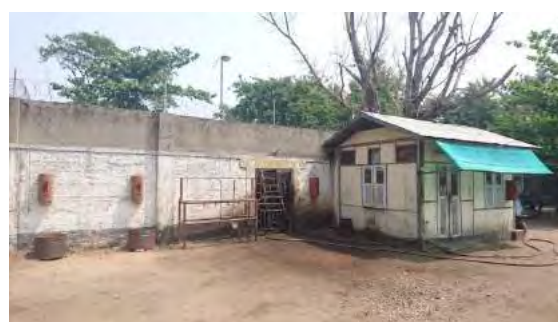
(b) 燃料ポンプ室（給油設備）
