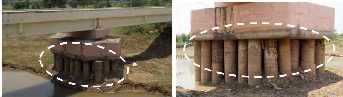
図 5.5.24 杭基礎の損傷（Bridge No.719）
