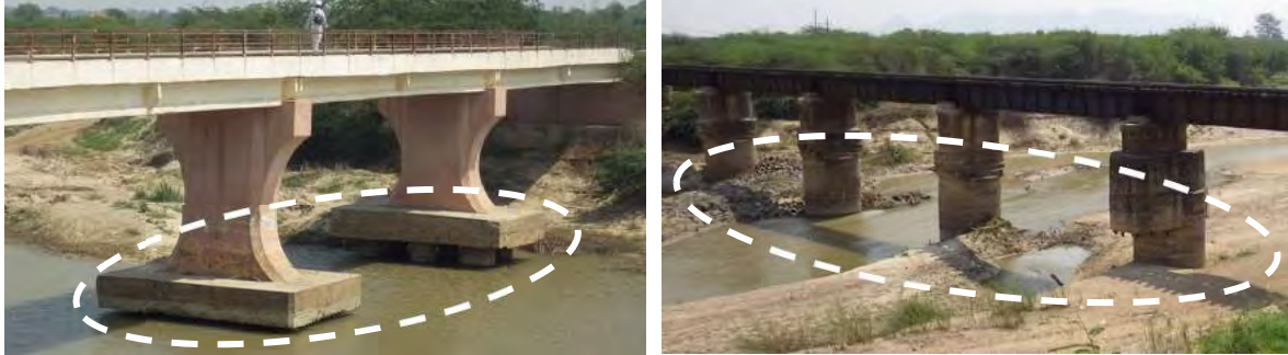
図 5.5.21 流水による基礎周辺部の洗掘（Bridge No.691）
