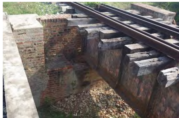
レンガ式橋台
