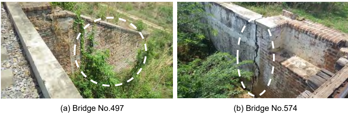
図 5.5.27 翼壁・擁壁の老朽化および経年劣化に伴う構造的不安定性
