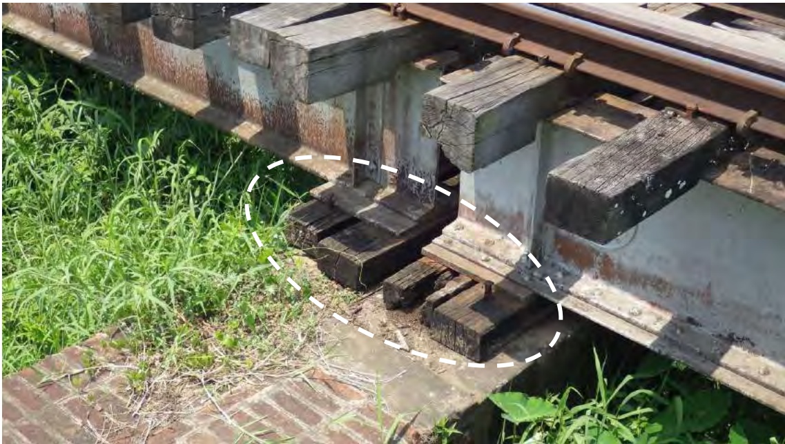
図 5.5.3 不安定な沓構造（Bridge No.325）
