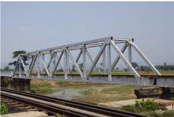
鋼製下路式トラス桁
