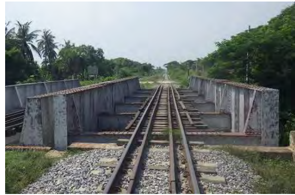
鋼製下路式プレートガーダー
