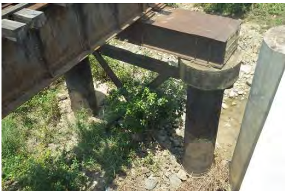
コンクリート充填鋼管式橋脚
