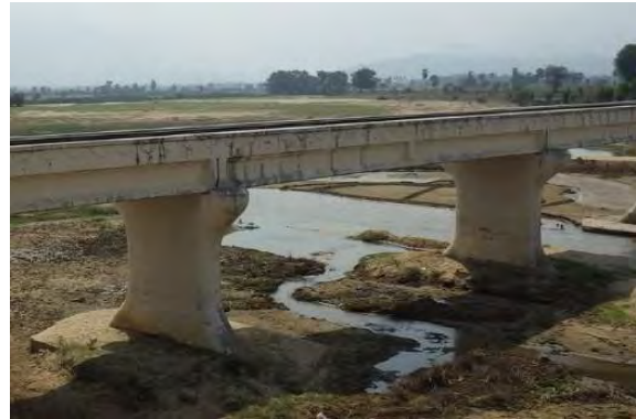
鉄筋コンクリート式橋脚
