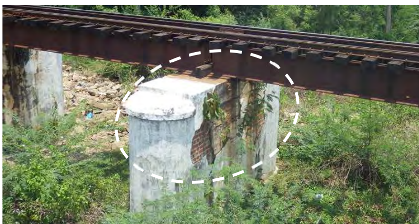
図 5.5.20 モルタル等による表面被覆（Bridge No.527）
