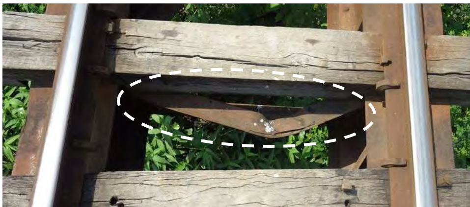
図 5.5.5 軌道下横構の変形（Bridge No.384）
