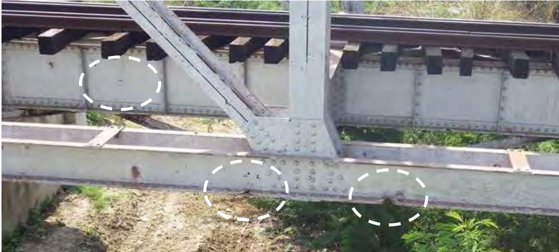
図 5.5.14 その他の構造部材の損傷 (Bridge No.683)
