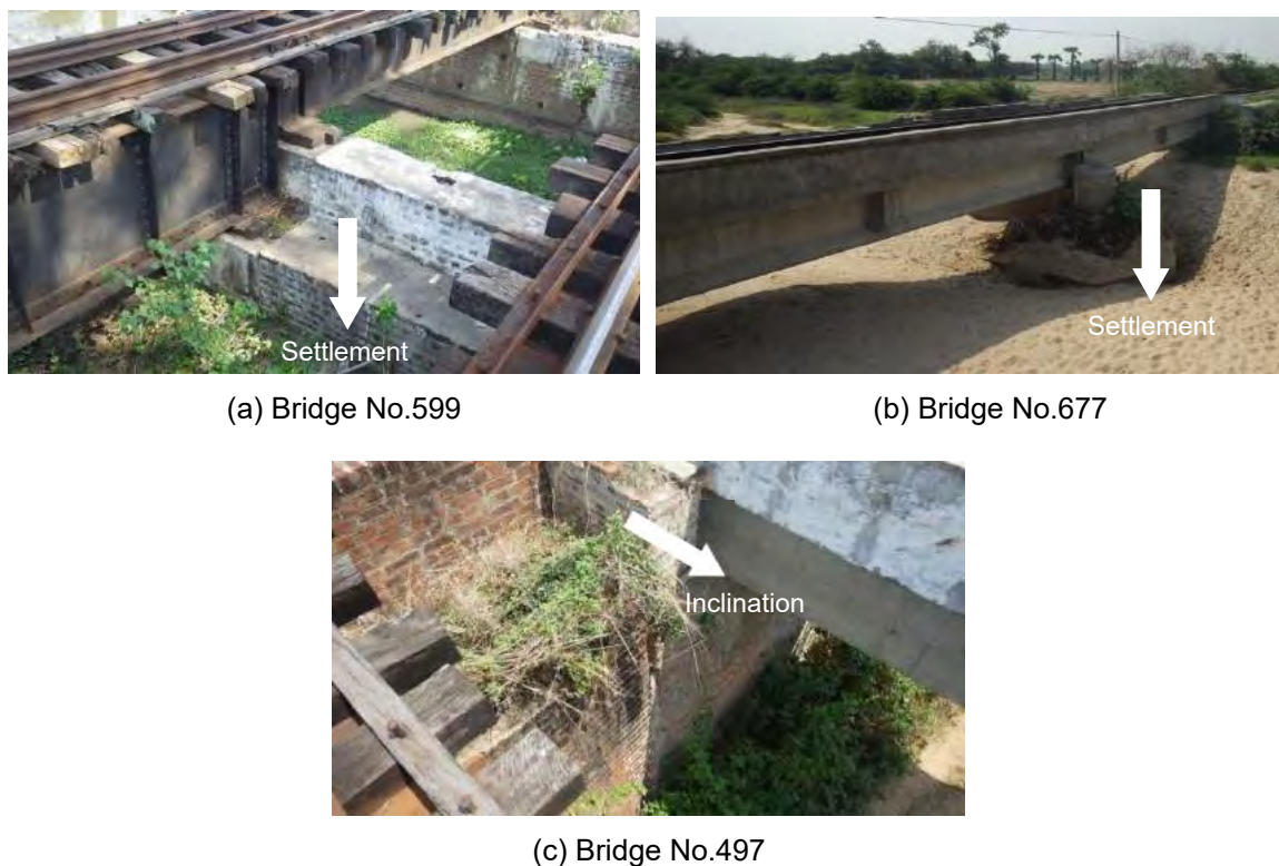
図 5.5.19 下部工基礎の支持力不足に伴う構造的不安定性
