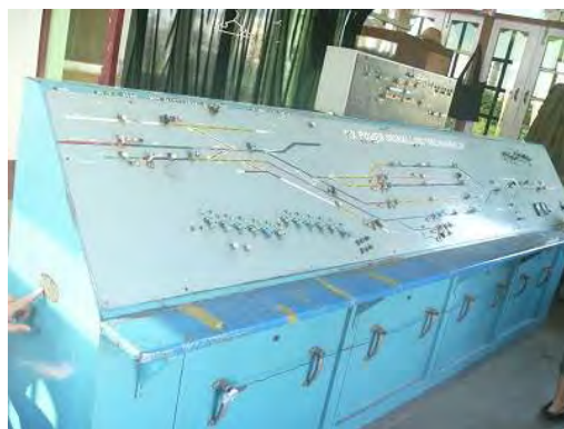
図 5.12.2 継電連動制御盤
