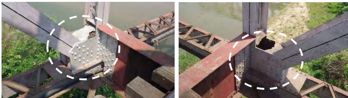
図 5.5.13 格点部の充填物（Bridge No.306）
