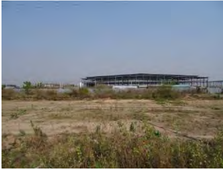
(a) 工場外観 (2017年3月)
