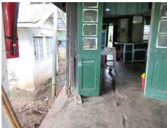
図 5.9.3 不同沈下
