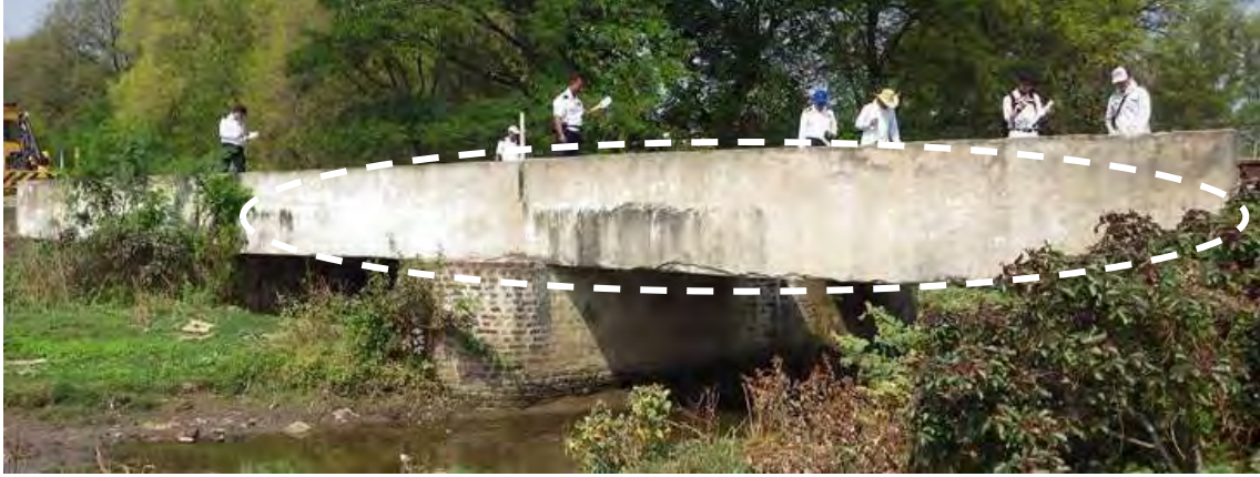
図 5.5.16 モルタル等による桁の表面被覆（Bridge No.436）
