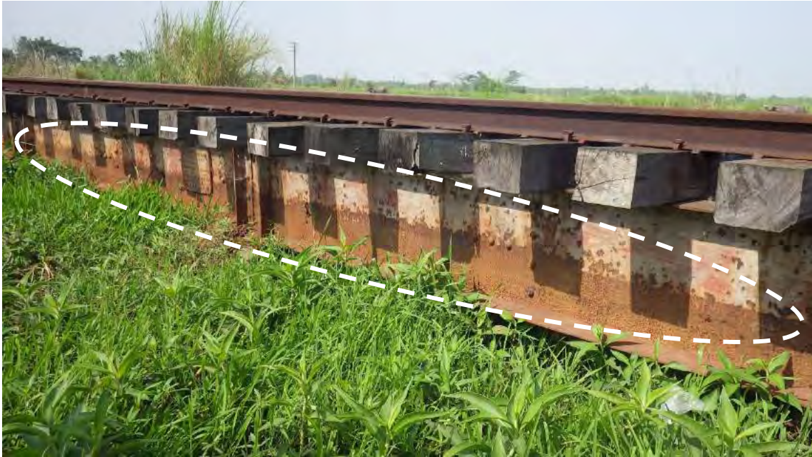
図 5.5.6 浸水による腐食（Bridge No.291）
