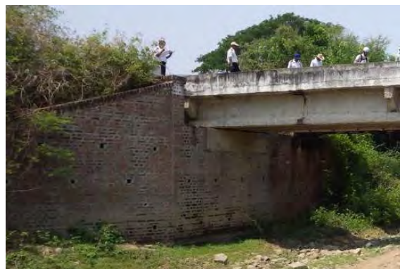
レンガ式橋台翼壁/擁壁
