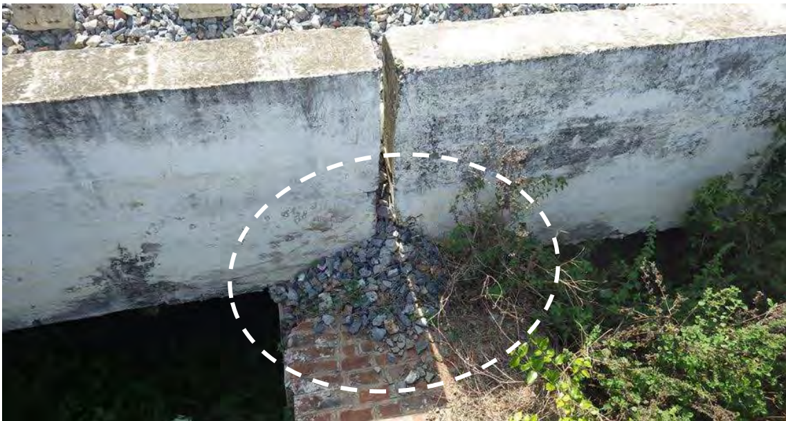
図 5.5.17 桁遊間部からのバラスト流出（Bridge No.586）
