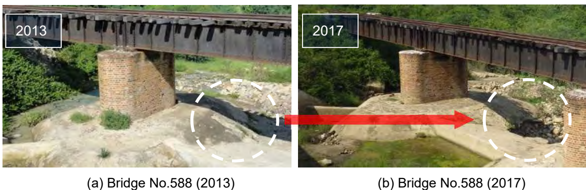
図 5.5.23 洗掘による損傷の発生（Bridge No.588）
