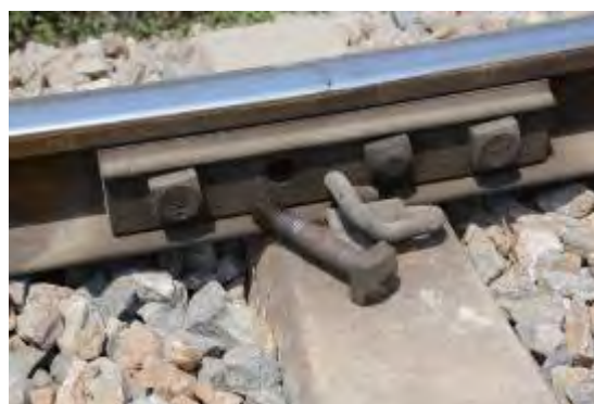
図 5.3.4 レール継ぎ目ボルトの欠落
