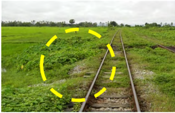
図 5.4.2 盛土の断面欠損 (Mile 44)
