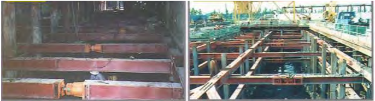
Hình 6.1.1.1 Hệ khung chống đỡ sử dụng kích thủy lực
