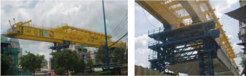
図 6.1.8 鋼製箱桁式ガントリーによる PC-U 桁架設状況 (1 号線の例)
