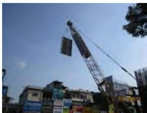
図 6.2.12 クレーン積荷が道路上に出ている状況(ハノイ市都市鉄道)
