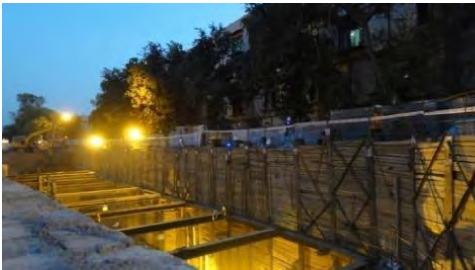
図 6.2.18 駅の掘削工事における OSV 計測状況(デリー地下鉄)
