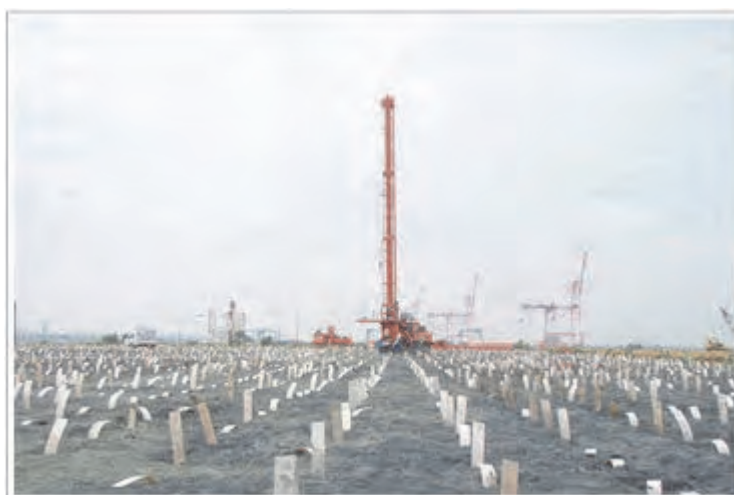
図 6.2.3 プラスチックボードドレーン工法施工事例
