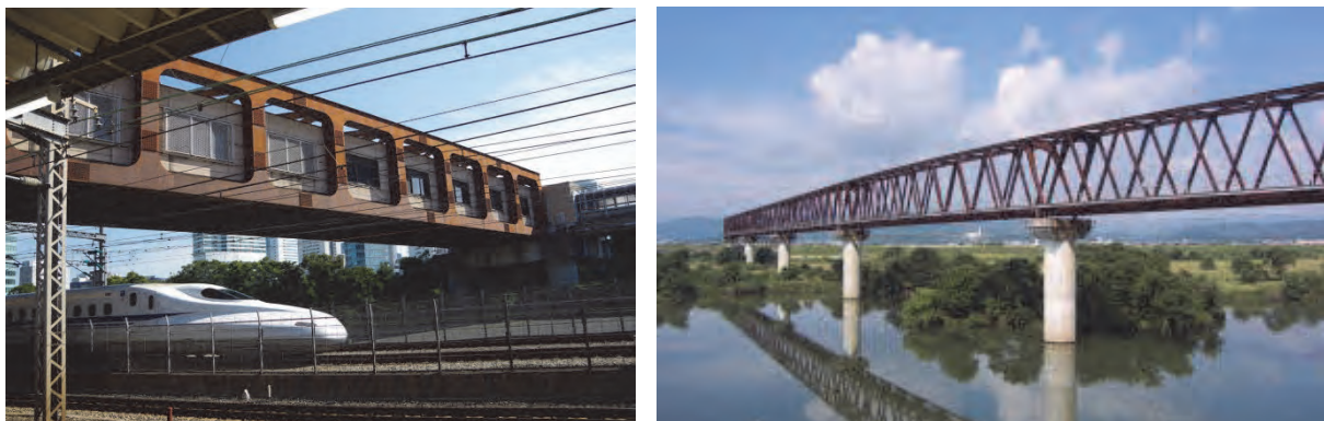
図 6.2.9 耐候性鋼材を用いた橋梁施工事例
