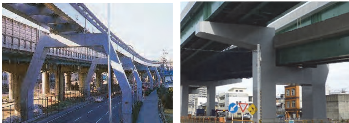
図 6.2.12 鋼製橋脚を用いた橋梁施工事例
