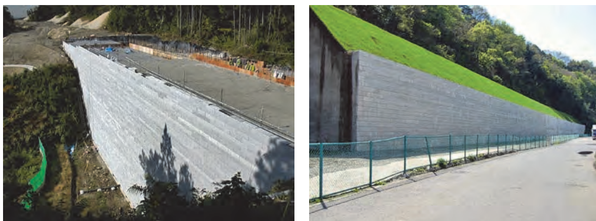
図 6.2.5 軽量盛土工法施工事例
