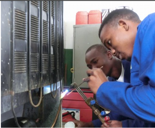
写真-3: マシャバ CFP・冷凍空調コース 冷蔵庫冷媒配管補修作業実習の状況
