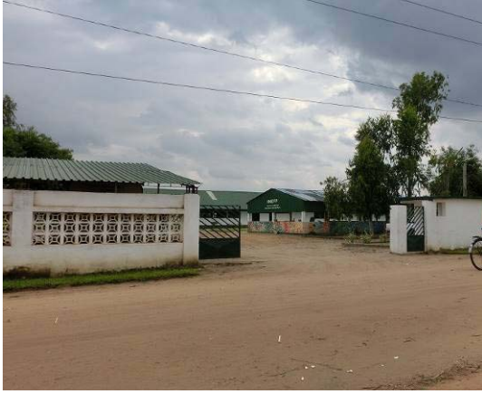
写真-7：キリマネ CFP・敷地外からの正面入り口
