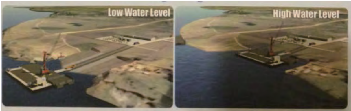
自然河岸を掘り込んで斜路を建設した浮棧橋（シミコン港パンフレット）
