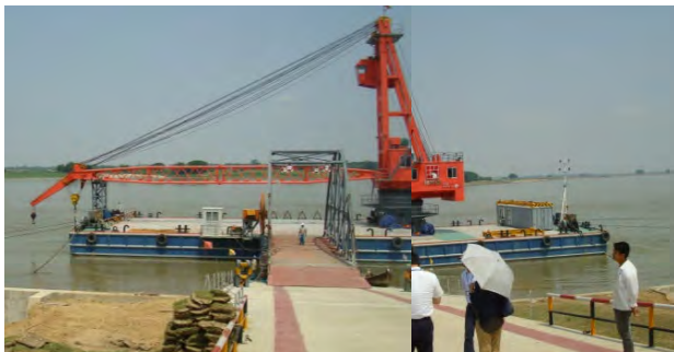
写真 2-2-19 シミコン港ポンツーンの状態
