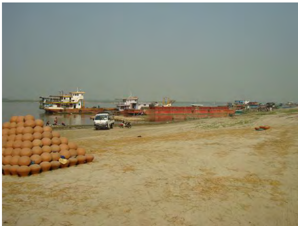
写真 13： マンダレー港建設サイト 川側全景 連続写真 (5/6) 2017 年 2 月 19 日撮影
