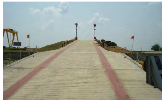
写真 2-2-20 シミコン港斜路の状態
