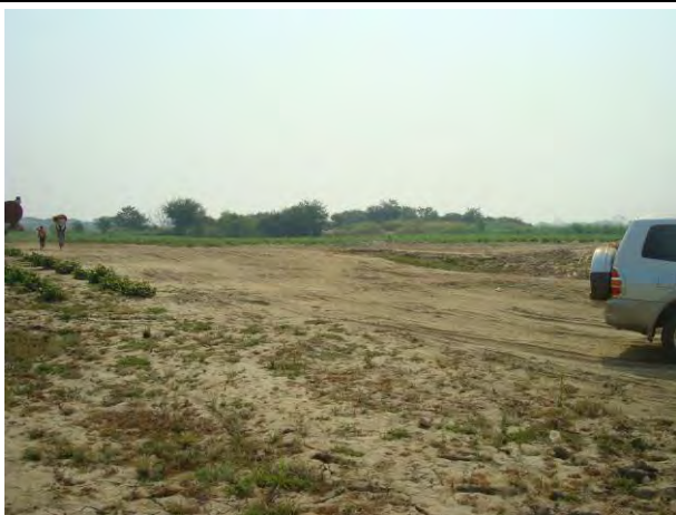
写真 7： マンダレー港建設サイト 陸側全景 連続写真 (7/8) 2017 年 2 月 19 日撮影
