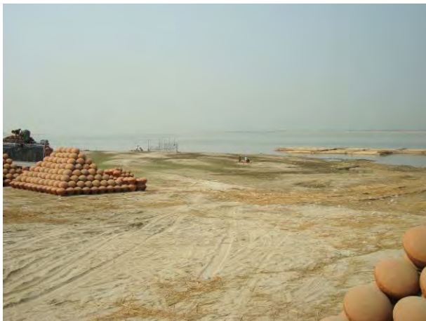
写真 9： マンダレー港建設サイト 川側全景 連続写真 (1/6) 2017 年 2 月 19 日撮影
