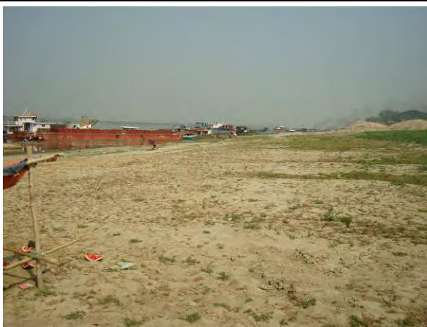
写真 1： マンダレー港建設サイト 陸側全景 連続写真 (1/8) 2017 年 2 月 19 日撮影
