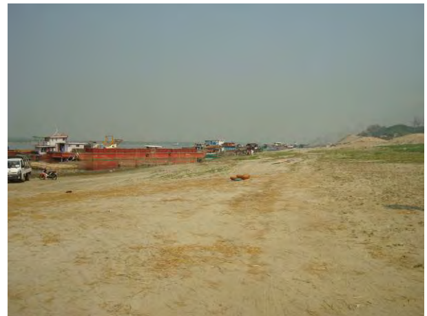
写真 14： マンダレー港建設サイト 川側全景 連続写真 (6/6)) 2017 年 2 月 19 日撮影
