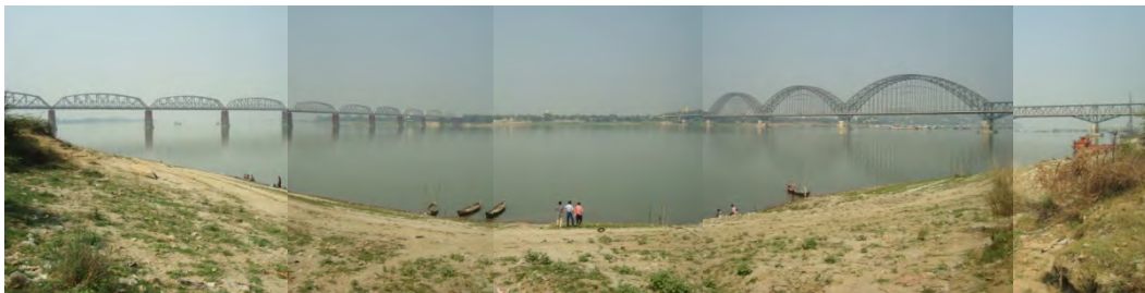
写真 2-2-12 候補地 2 の河川側の状況
