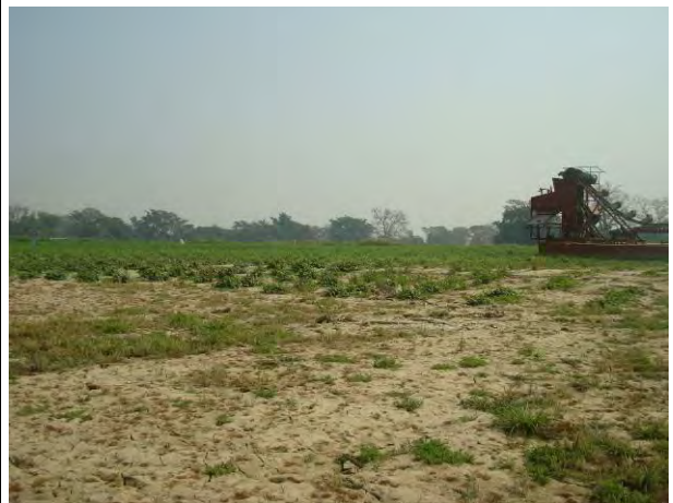
写真 4： マンダレー港建設サイト 陸側全景 連続写真 (4/8) 2017 年 2 月 19 日撮影
