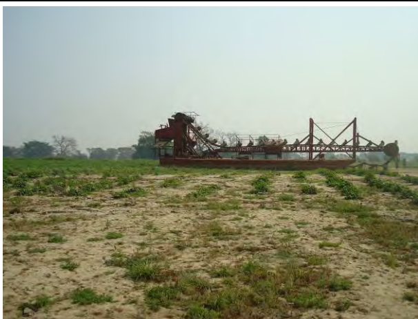
写真 5： マンダレー港建設サイト 陸側全景 連続写真 (5/8) 2017 年 2 月 19 日撮影
