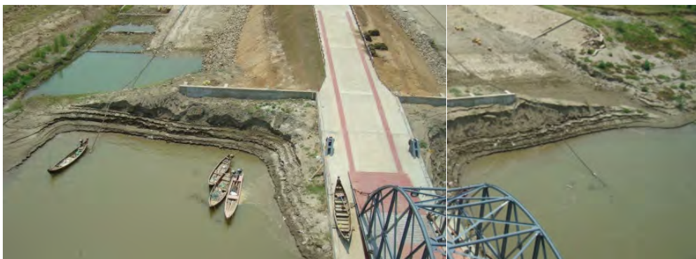
写真 2-2-23 改良により建設された防砂壁
