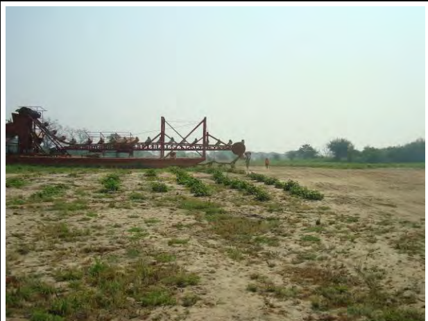
写真 6： マンダレー港建設サイト 陸側全景 連続写真 (6/8) 2017 年 2 月 19 日撮影
