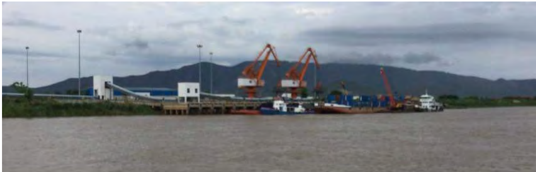
写真 2-2-24 タカウンの固定式栈橋
