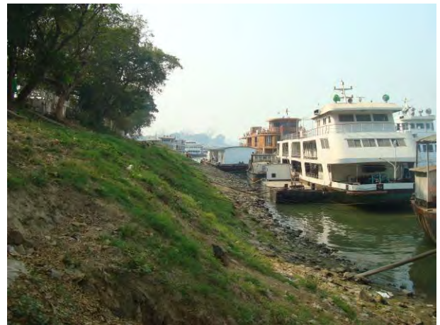
写真 26 : 民間客船用浮棧橋の状況 2017 年 2 月 19 日撮影
