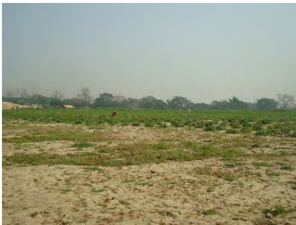
写真 3： マンダレー港建設サイト 陸側全景 連続写真 (3/8) 2017 年 2 月 19 日撮影
