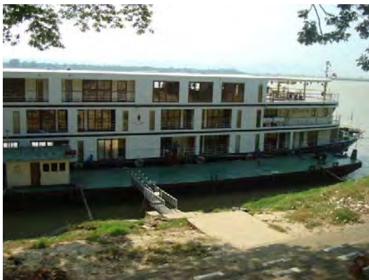
写真 2-2-8 民間クルーズ船用の着桟施設（ポンツーン）
