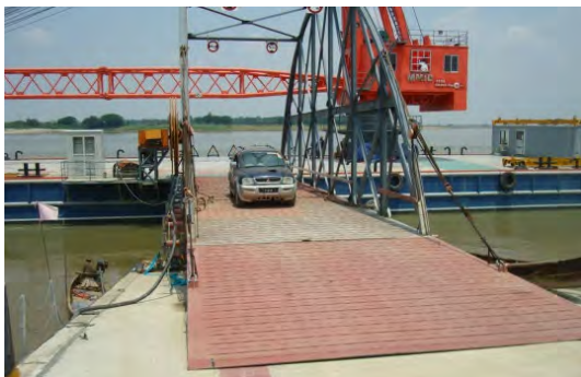
写真 2-2-21 ポンツーンへの連絡橋
