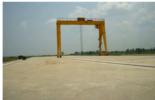
写真 2-2-22 斜路上側の貨物取扱ヤード
