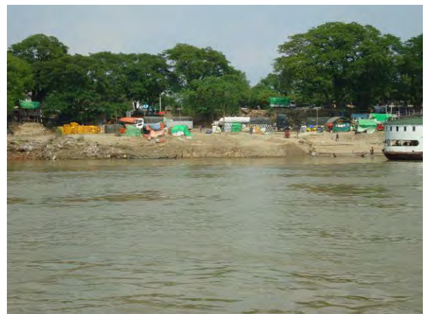
写真 30 : 既存自然河岸荷役場所の状況 河川上からの連続写真 (2/2) 2017 年 5 月 14 日撮影
