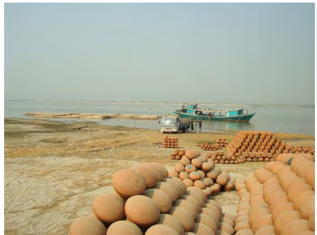
写真 10： マンダレー港建設サイト 川側全景 連続写真 (2/6) 2017 年 2 月 19 日撮影
