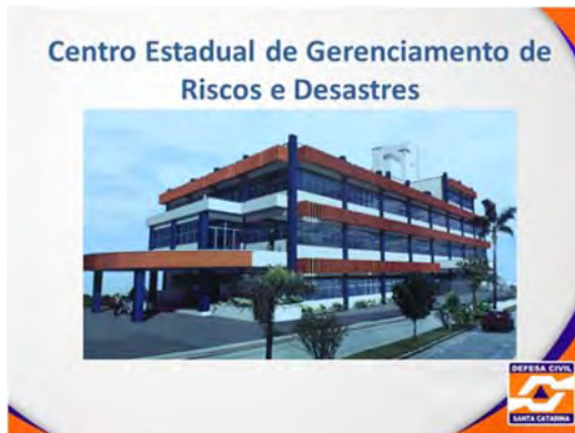
現在建設が進められている州の災害リスク管理センター完成予想図
