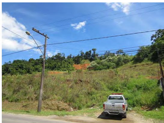
2008年に地すべりが発生した現場(MOV23.4)。被害を受けたガソリンスタンドは、今はない。現在はメモリー(?)をつけて測定中とのこと。ボーリングの結果、地層が30mの深さまであり、地質が古いので地すべりが起こりやすいとのこと。
