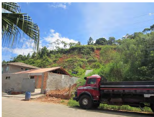
同じく2008年に地すべりが発生した現場(MOV23.6)。3軒の家屋が被害を受け、うちまだ1軒は下に埋まっている。雨が降れば地区に警報を流すシステムを導入する予定とのこと。
