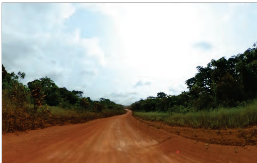
Fig. 47 Route Principale dans une concession
